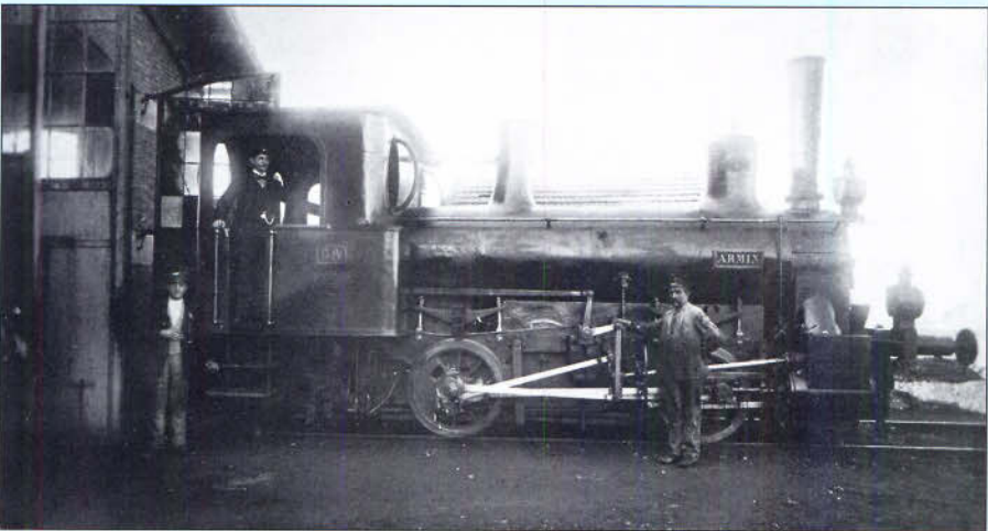
Bild 152 (links oben): Eine anscheinend durch Flankenfahrt beschädigte D VI wird von der D IV HELICON verschoben.
