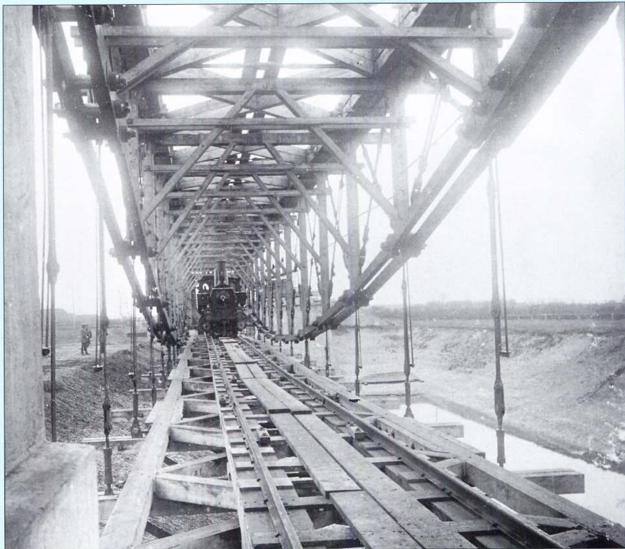
Bild 164 (oben links): D V ULRICHBERG bei der Belastungsprobe einer von Eisenbahnpionieren erbauten Behelfsbrücke.
