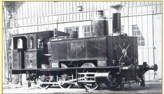
Bild 46: Eine weitere Aufnahme der schweren C-Bergzug-Tenderlokomotiven (vergleiche Bild 44) zeigt die 1871 von der MBG Karlsruhe gelieferte "Belfort". Im Gegensatz zur "Marxburg" sind bei ihr die Wasserkästen bis zur Rauchkammertür vorgezogen worden.
