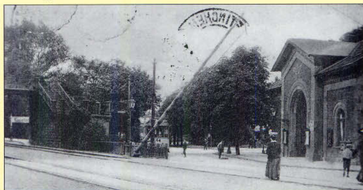
Bild 215: Osnabrück Hasetor an der Strecke Osnabrück – Rheine: Die Lage des Gegengewichts läßt erkennen, daß die 45°-Stellung offenbar die normale Position ist – schließlich mußte die Schranke noch von Hand heruntergedrückt werden. Foto: Archiv Hesselink
