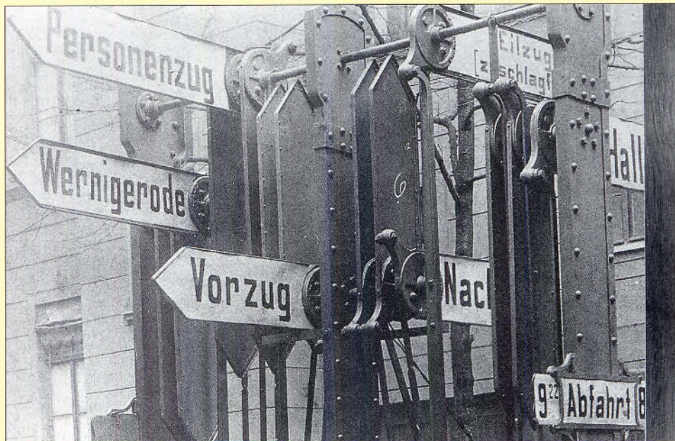
Bild 213: Signale für den Fahrgast: ein Zugabfahrtsanzeiger (auch "Hampelmann" genannt) im Bahnhof Halberstadt. Noch heute sind derartige Geräte auf manchen Stationen anzutreffen.
