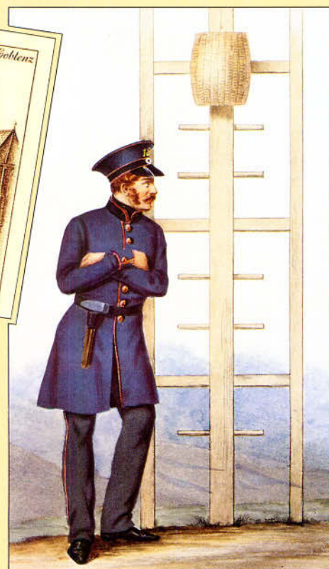
Bild 193 (rechts): Kurios muten heutzutage solche Ballon-signale (um 1850) an. Per Handseil wurde die Höhe des "Ballons" (meist aus Korbgeflecht) eingestellt und damit "Halt" oder "Freie Fahrt" signalisiert. Abbildung: Sammlung Merker
