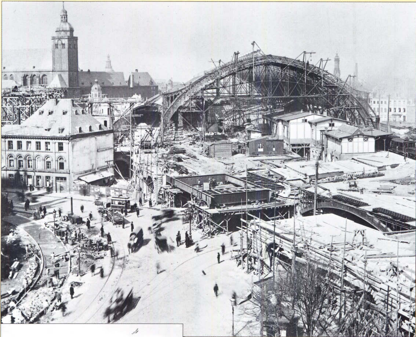
Bild 185: Die Großbaustelle Hauptbahnhof Köln im Jahre 1892. Während der Bauarbeiten mußte der Schienenverkehr zwischen dem alten Centralbahnhof und Deutz weiterlaufen. Foto: Rheinisches Bildarchiv
