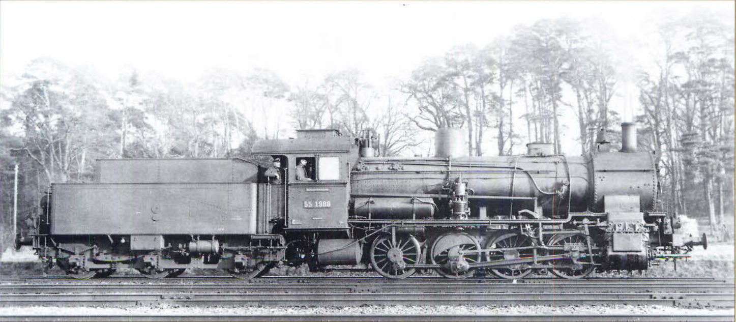
Bild 17: Die (G 8) Hannover 4818, 1911 von der Hanomag mit der Fabriknummer 5996 gebaut, besaß Lentz-Ventilsteuerung. Die DRG übernahm sie mit der Betriebsnummer 55 1988. Die Lokomotive ist mit dem Tender 3 T 16,5 gekuppelt. Foto: Sammlung Weisbrod
