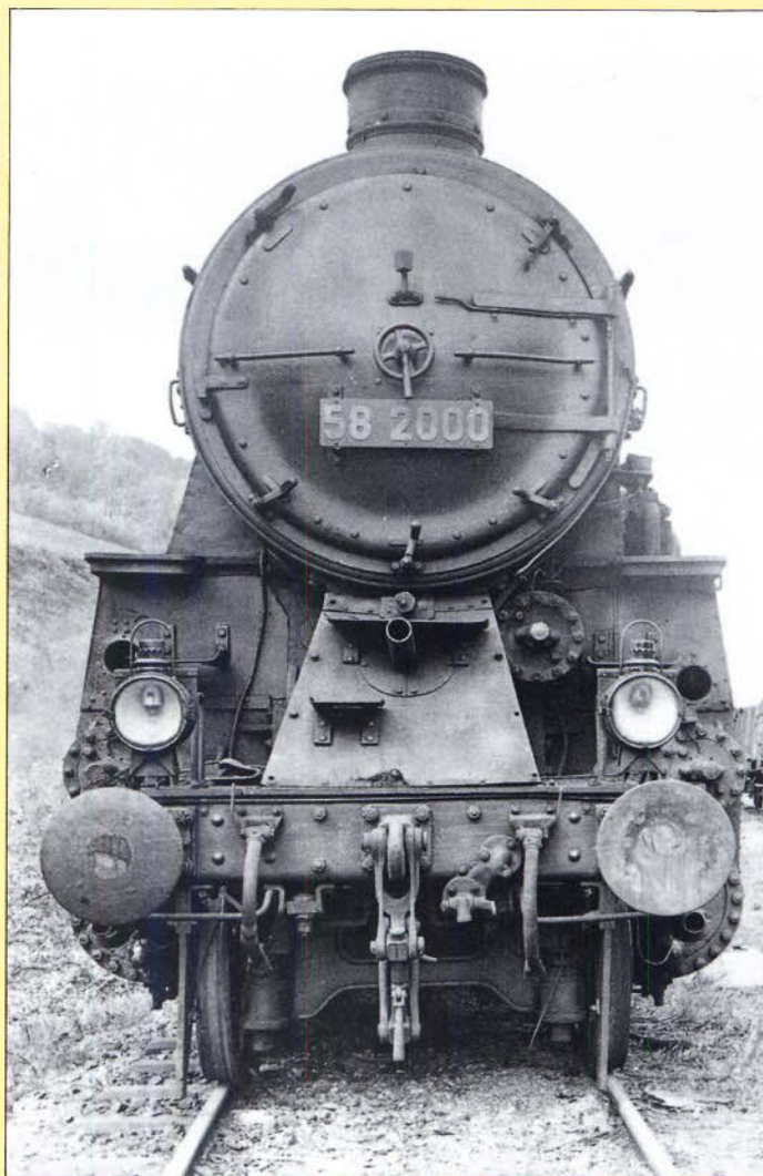
Bilder 8 und 9: Fast kein Unterschied ist bei den Frontansichten der G 12 zu bemerken. Die 58 2000 hat jedoch als Schornstein nicht mehr die "Garbesche Angströhre", sondern schon den Schornstein größeren Durchmessers. Beide Lokomotiven haben aber noch keine elektrische Beleuchtung! Fotos: C. Bellingrodt
