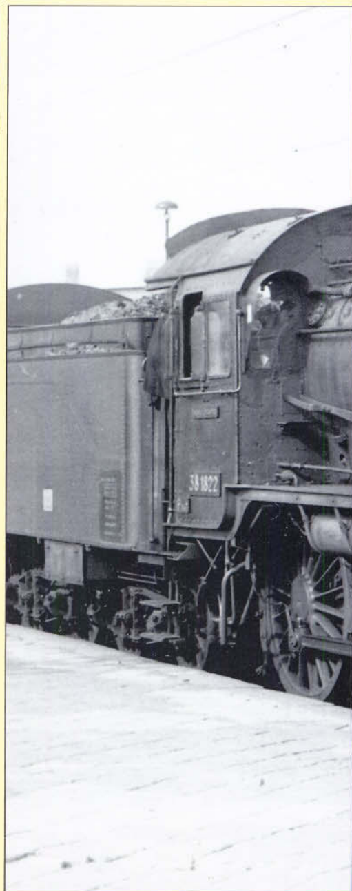
Bild 68: Die DR 38 1822 ist mit einem Giesl-Ejektor und Läutewerk ausgerüstet. Trotz der schlechten Wasserqualität in den ostdeutschen Bws besaß sie keinen Speisedom. Foto: K. Kieper
