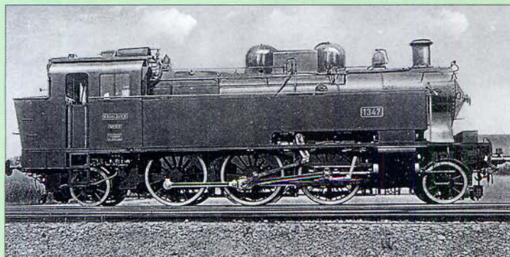
Bild 140: Die 1347 gehört ebenfalls zum Baulos von 1911 mit geraden Wasserkästen und spitzer Rauchkammertür.
