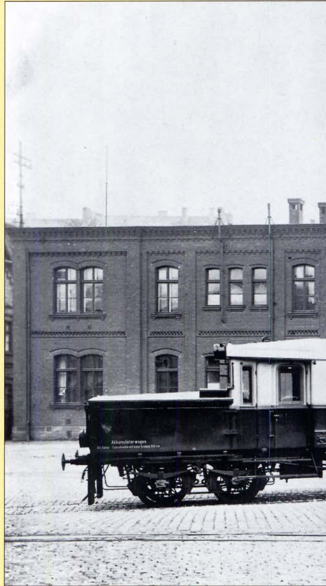
Bild 141: Der 1911 von Van de Zypen gebaute AT 3 377/378 HANNOVER mit Enddrehgestellen verfügte über Abteile II., III. und IV. Klasse.
