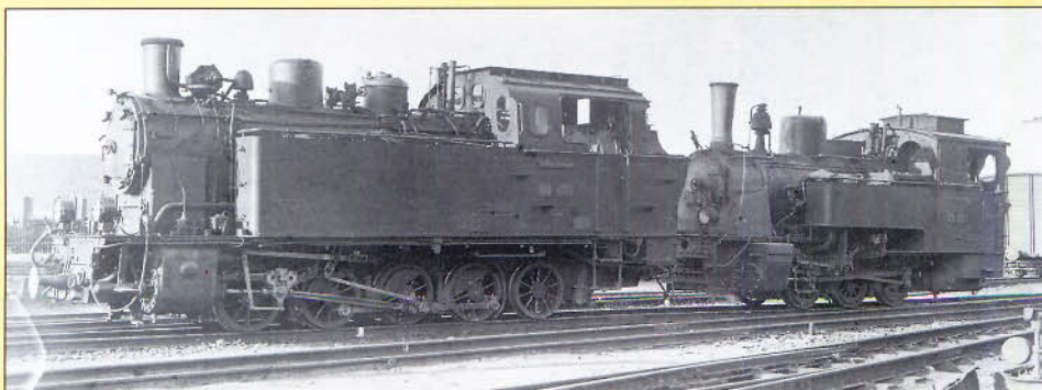
Bild 60 (Mitte): Die 99 182 im Lieferzustand. Ihr seitliches Nummernschild wurde an der Verkleidung der Einströmröhre angebracht, das Gattungsschild in der Mitte des Wasserkastens. Die Anordnung wurde jedoch bald geändert.
