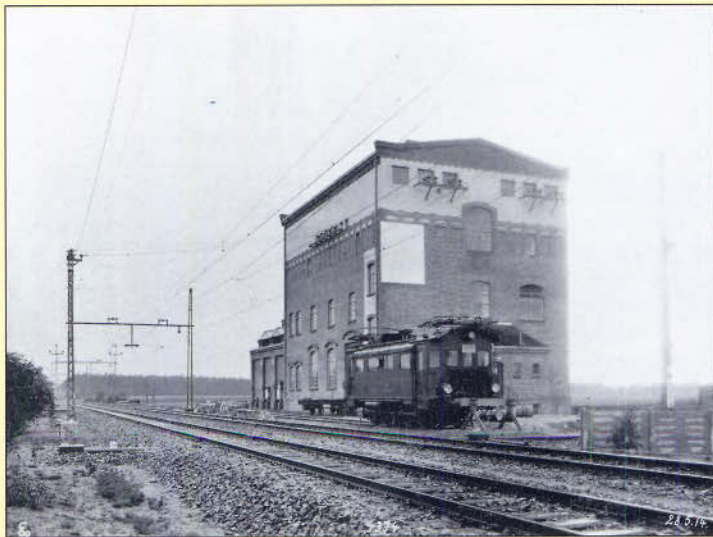
Bild 73: Unterwerk Marke zwischen Bitterfeld und Dessau am 28. Mai 1914. Davor die an die Fahrleitung angeschlossene EG 502.
