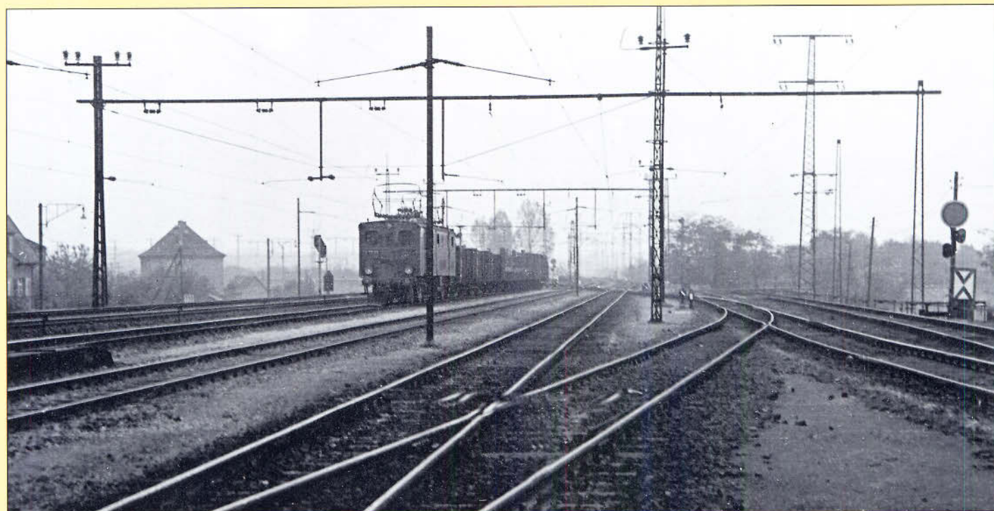
Bild 112: E 77 73 (frühere EG 723 Halle) befährt mit einem Güterzug den Güterring bei Leipzig. Hier ist die unter Verwendung von Quertragwerken errichtete Fahrleitungsanlage deutlich zu sehen.
