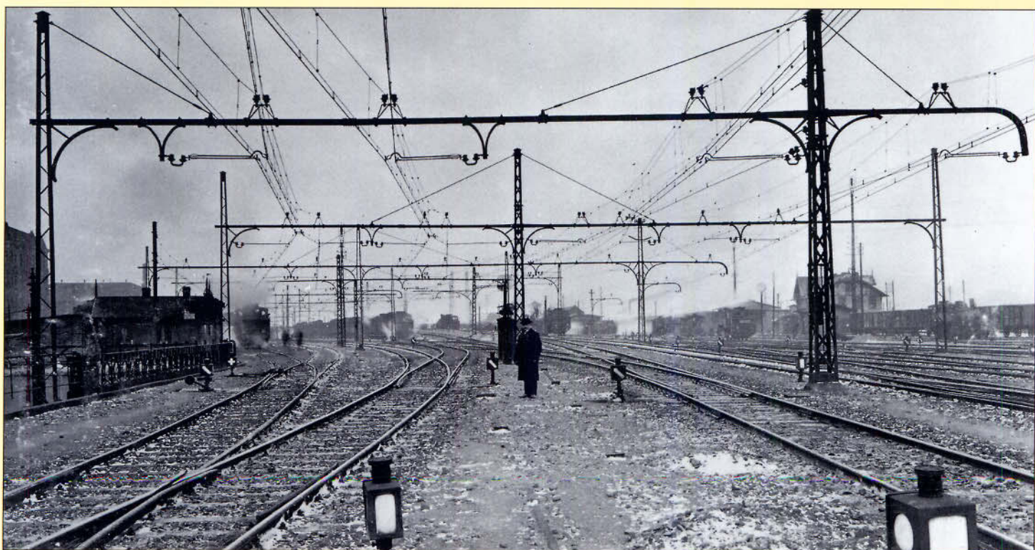
Bilder 27 und 28 (oben und unten): Die Fahrleitungsanlagen in Ohlsdorf 1906. Vor dem Lokschuppen zwei Triebwageneinheiten. Vorherrschend war noch der Dampfbetrieb. Abb.: Siemens Forum München
