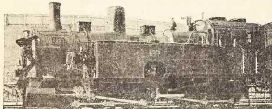
Фиг. 373. Танковый паровозъ системы Nagans'a 1903 г.
