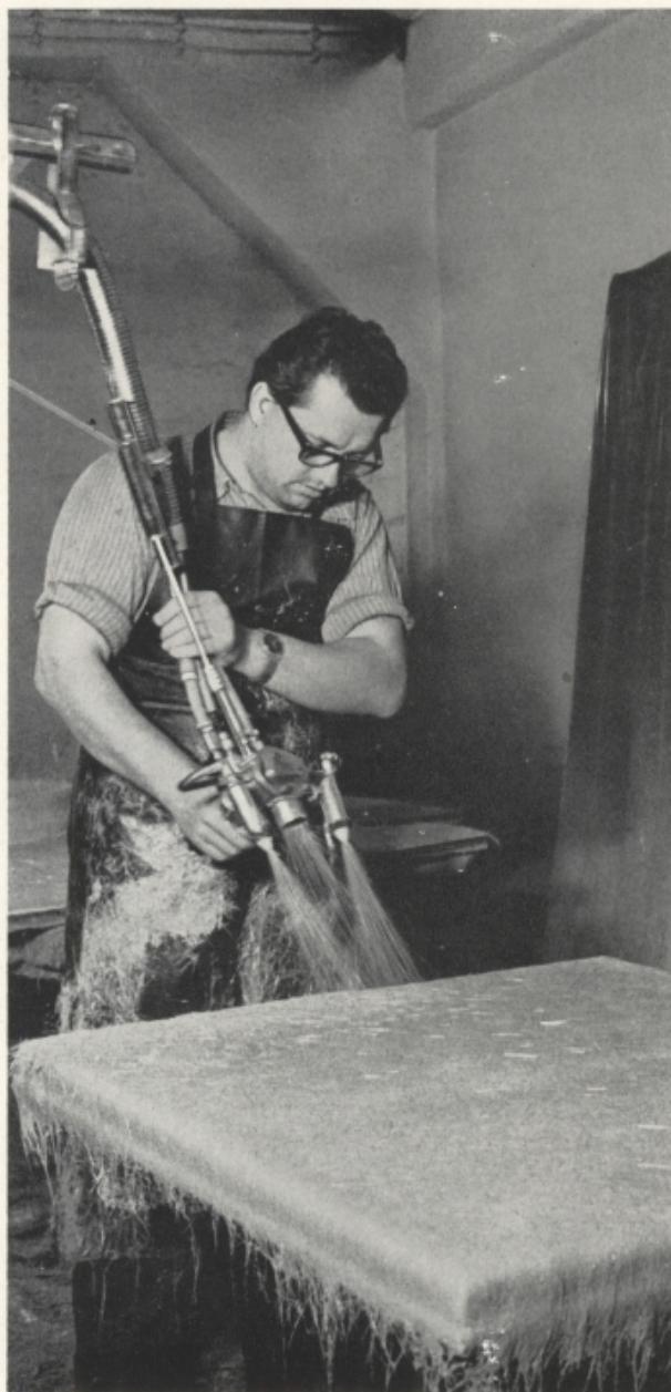
GUP-Spritzen eines Toilettenfußbodens
