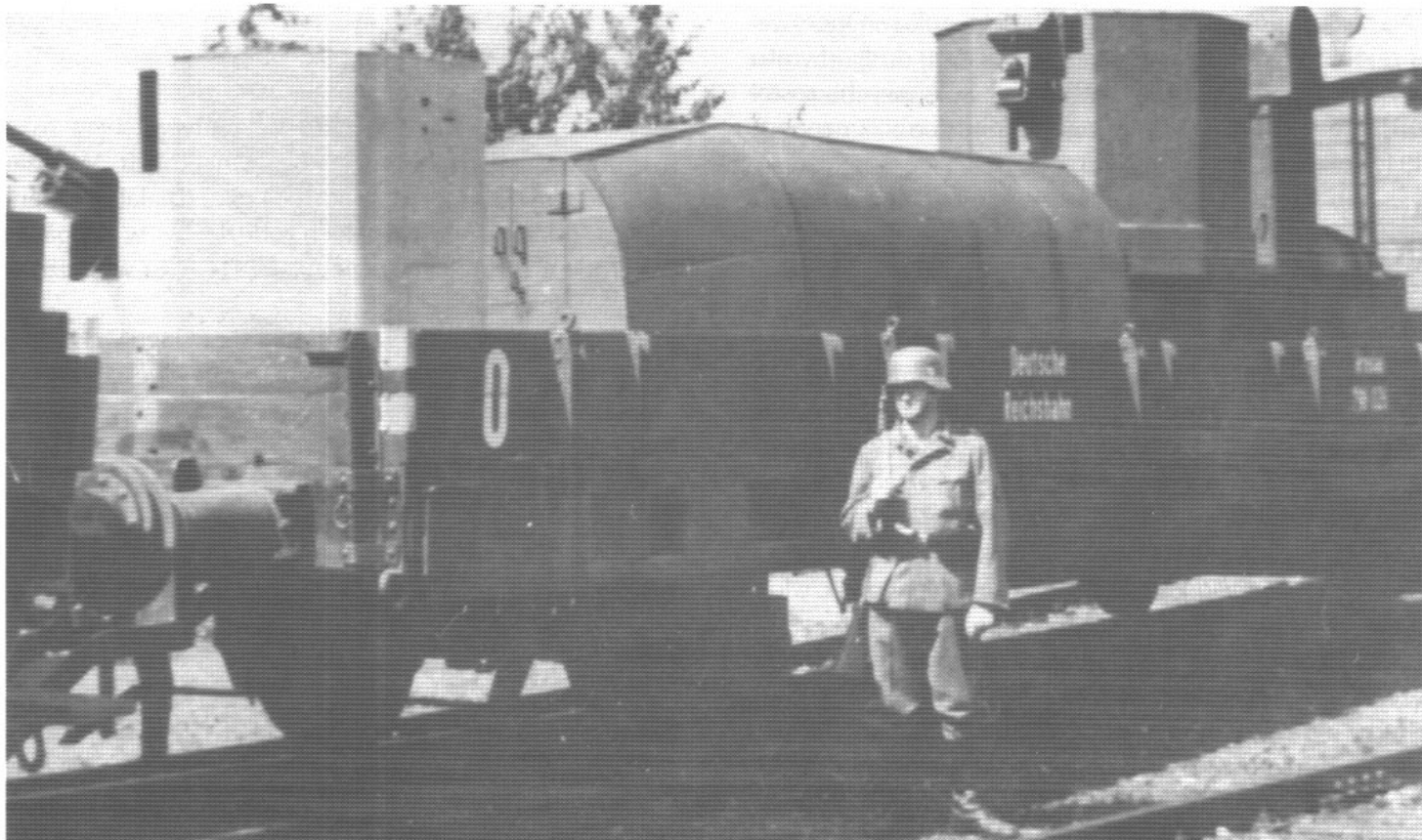
Pociąg pancerny Nr. 4, uzbrojenie wagonu artyleryjskiego stanowi armata kalibru 37 mm, 1939 rok. The armoured train Nr. 4. Note 37 mm gun mounted in artillery wagon [Prof. Dr. W. Sawodny]
