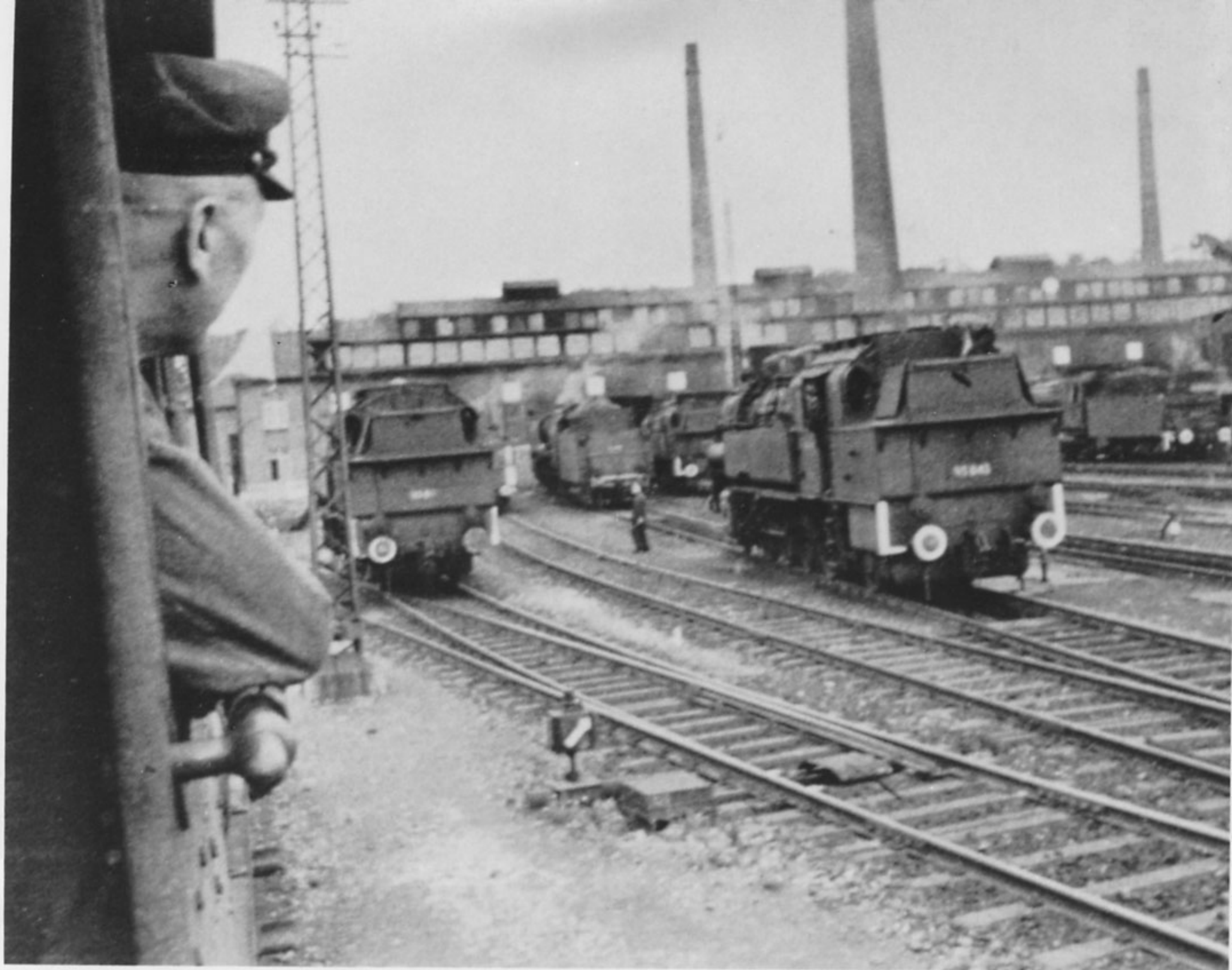
Frühjahr 1943: DR-Loks der Baureihe 93 5 mit weißem Verdunklungsanstrich auf dem Wasserkasten und den Puffern. Im Hintergrund ein deutsches Bahnbetriebswerk
