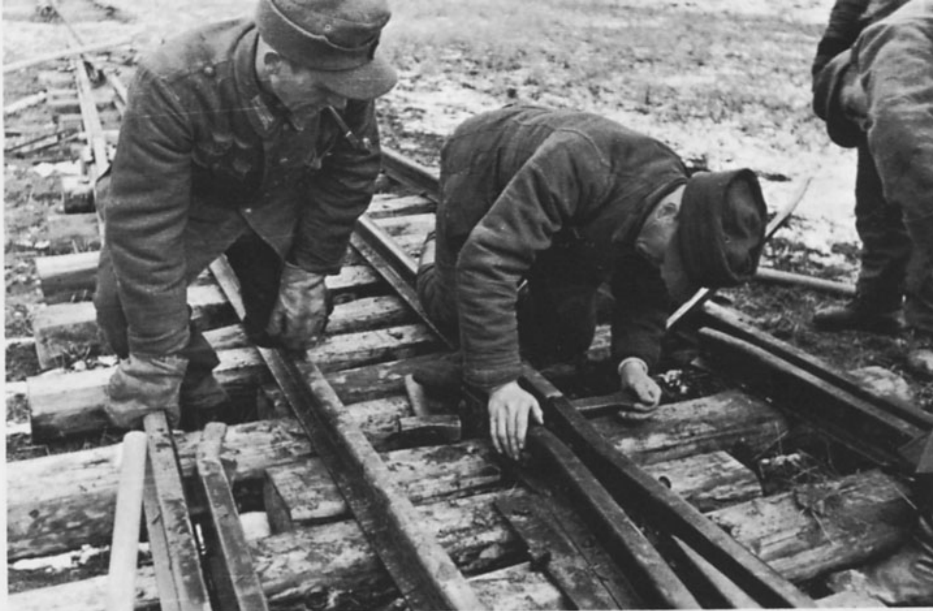
Einer von 50 000 Kilometern: Unweit von Kiew legen Eisenbahnpioniere neue Feldbahngleise. Oktober 1941
