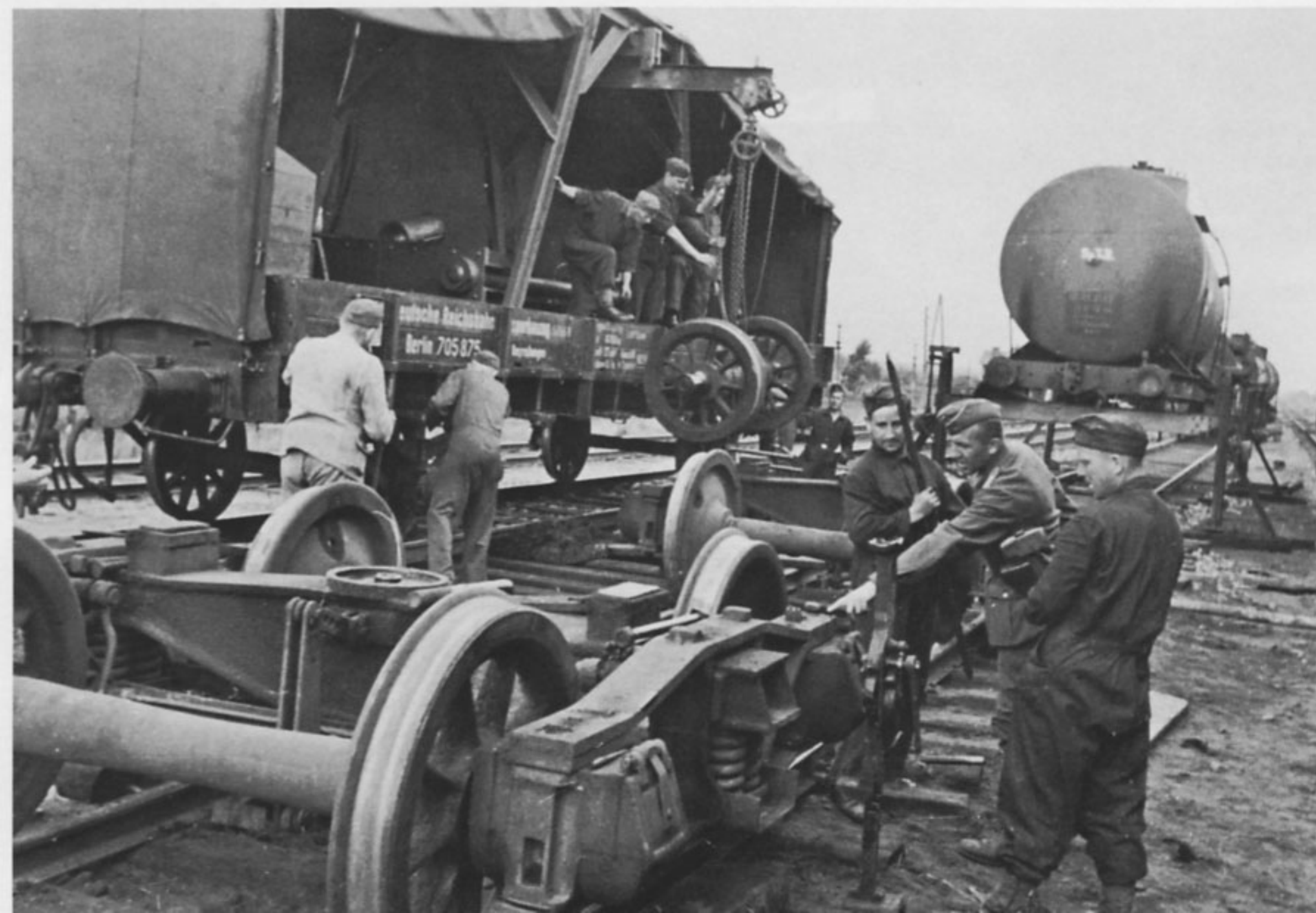
10 000 km umgenagelte Schienen: Umspurzug der Hauptseisenbahn- Direktion Süd (Kiew). Der Vierach- ser-Güterwagen von 1917 als Wohn- stätte der Eisen- bahnpioniere
