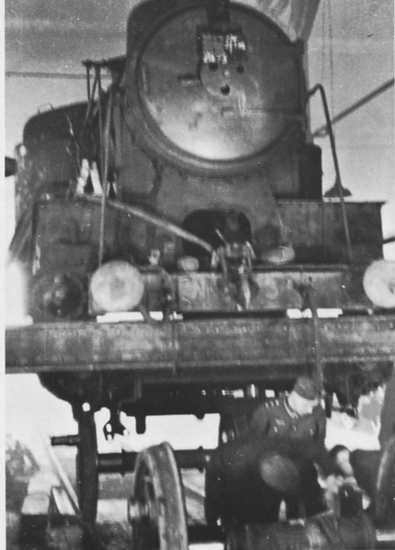
Russische Werklok auf dem Hebebock, bereit zur Umspurgung
