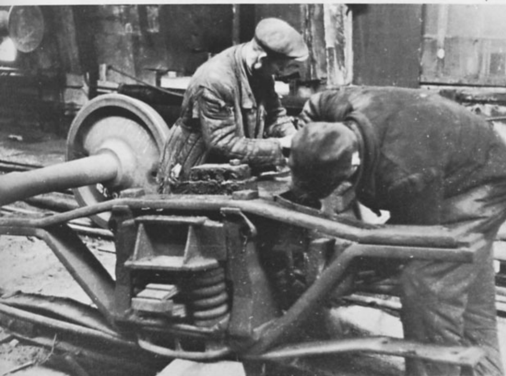
Russische Werklok auf dem Hebebock, bereit zur Umspurgung
