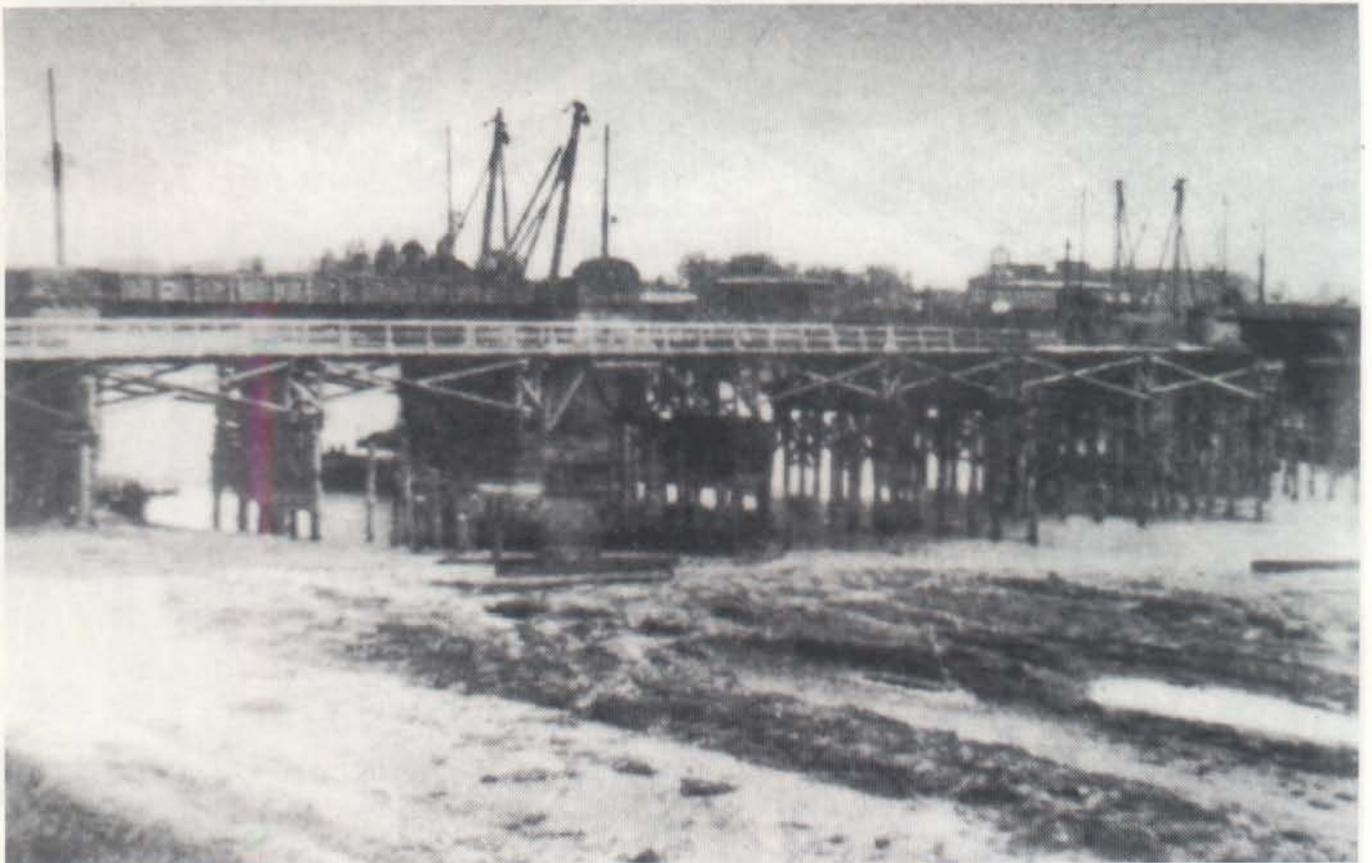
Warthebrücke 1939; Die Brücke wurde durch Behelfsmaterial wiederhergestellt, das zum Teil durch die Pioniere mitgeführt und zum anderen Teil vor Ort gewonnen wurde.
