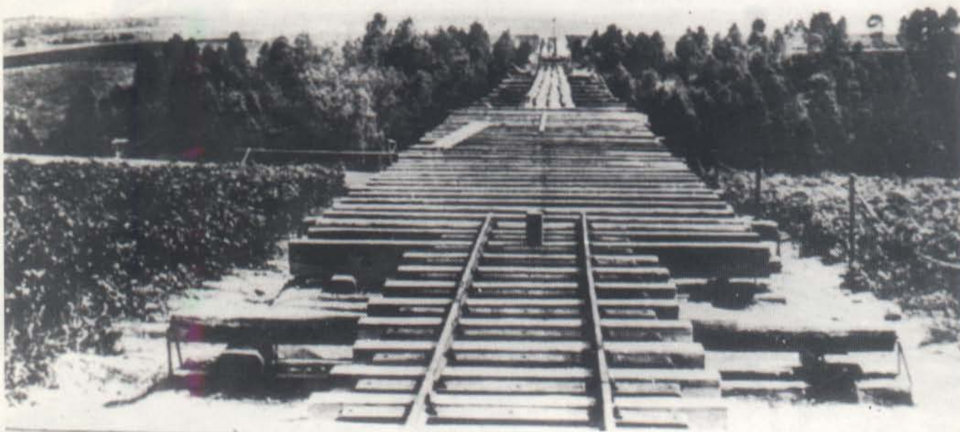
Bau einer Feldbahn durch deutsche Eisenbahn-Pioniere
