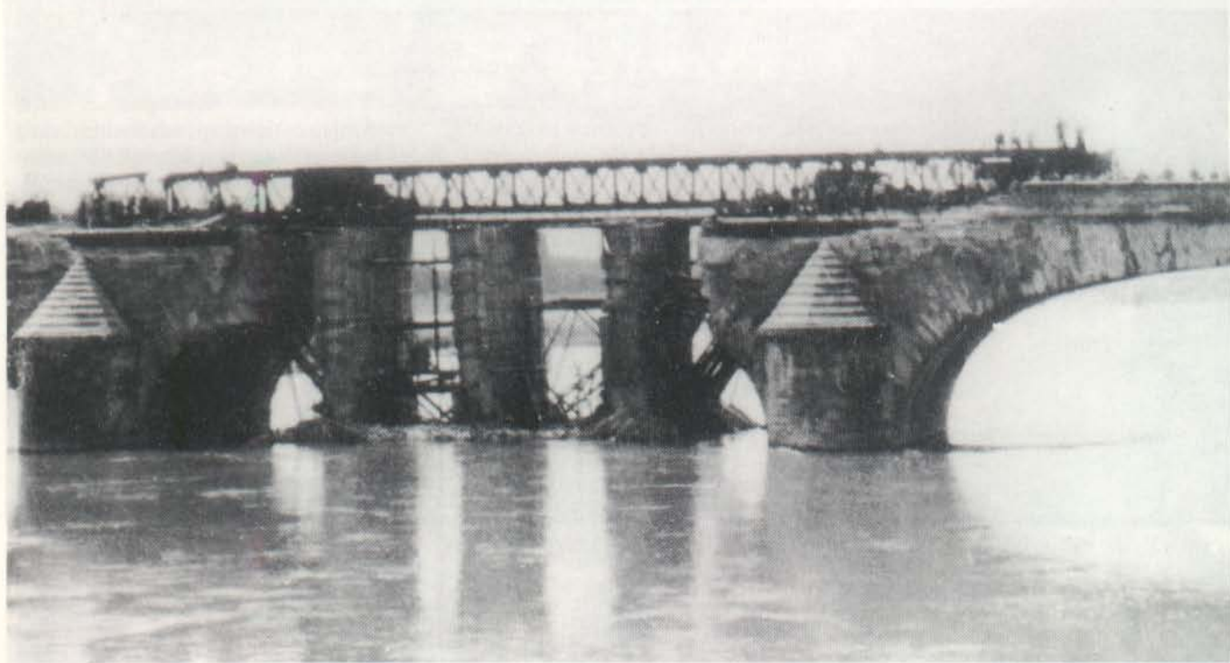
Die zerstörte Brücke wurde mit einem Kriegsbrückengerät MZ (Mittlere Zerlegbare Brücke) kriegsmäßig instandgesetzt.
