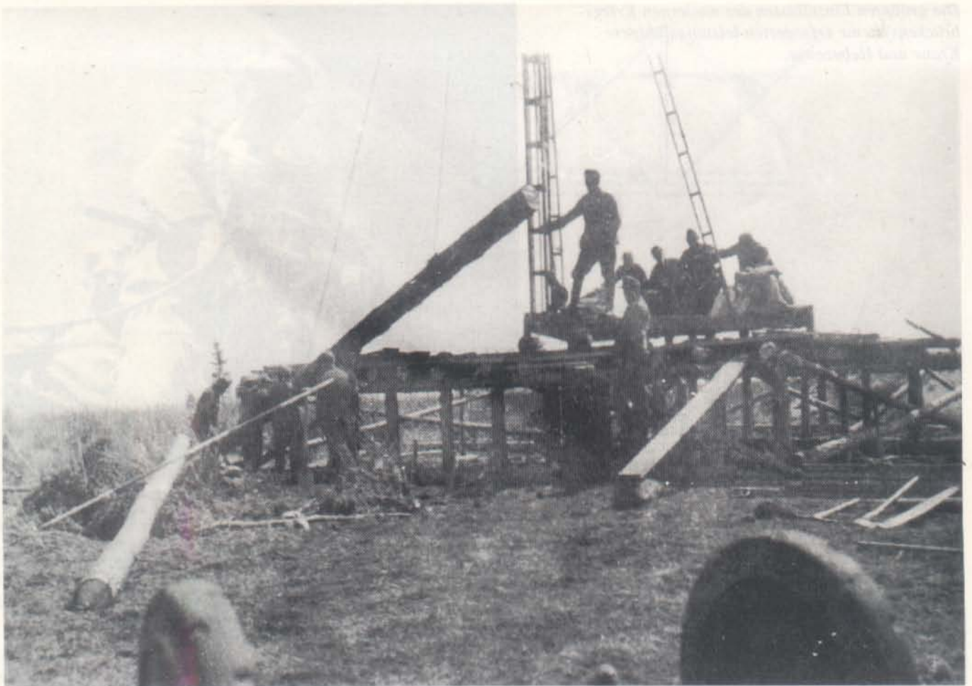
Mit behelfsmäßigen Mitteln aufgebautes Hebezeug. Handbetriebene Krane und Behelfshebezeuge hatten für die Wehrmacht keinesfalls an Bedeutung verloren.
