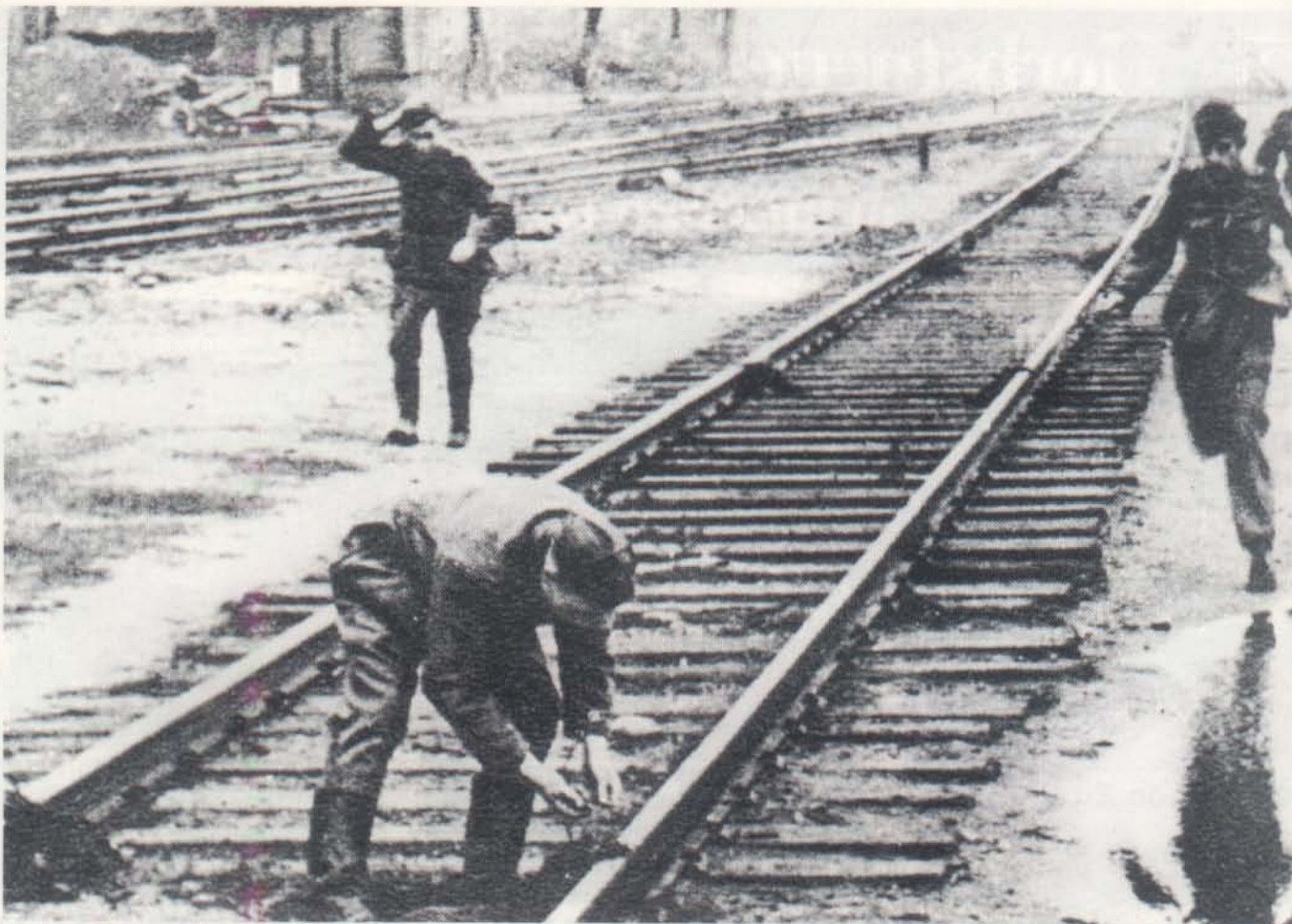
Die Gleise, die noch für die letzten Transporte gebraucht werden, werden von den Eisenbahn-Pionieren zur Sprengung vorbereitet.
