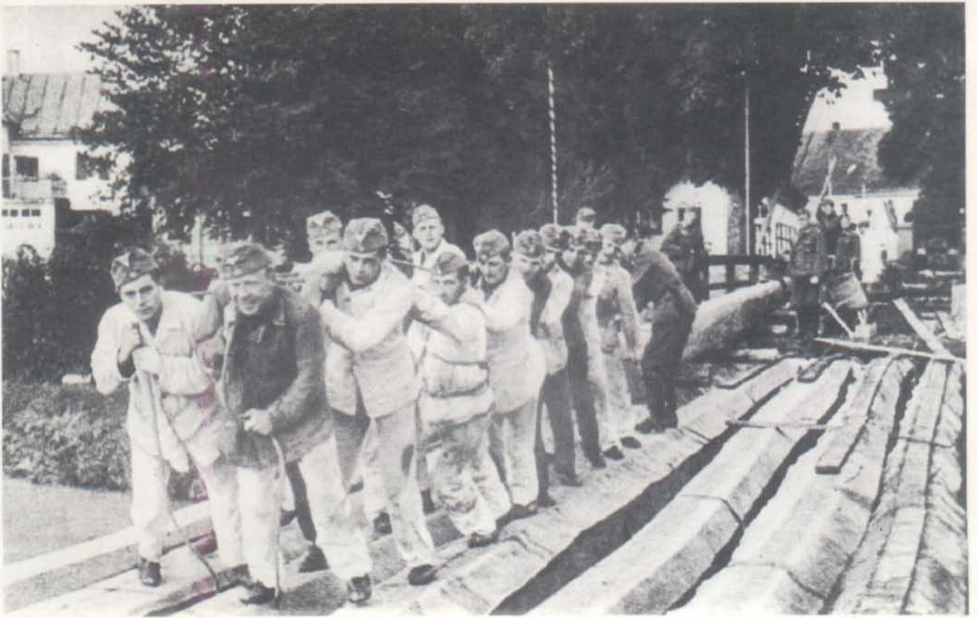
Hier: Eisenbahnbrücken werden mit behelfsmäßigen Mitteln wieder hergestellt. Während der Besetzung der tschechischen Grenzgebiete kommen die neu aufgestellten Eisenbahn-Pionier-Truppen erstmals zum Einsatz.
