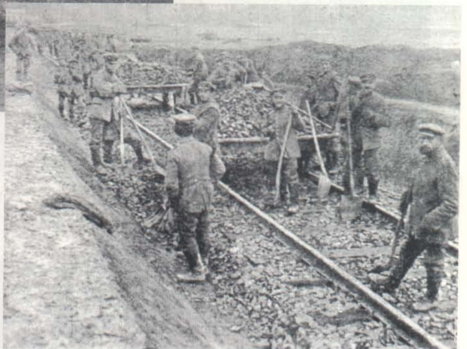
Rechts: Frankreich 1915; Pioniere bauen auf einer Landstraße ein Eisenbahn- gleis
