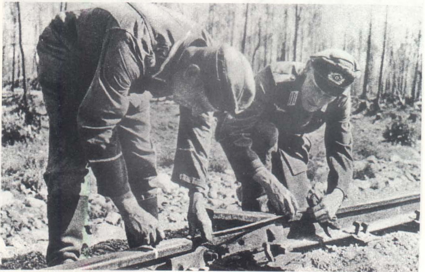
Auf manchen Strecken haben russische Partisanen Schienen gesprengt - Eisenbahn-Pioniere beheben den Schaden.
