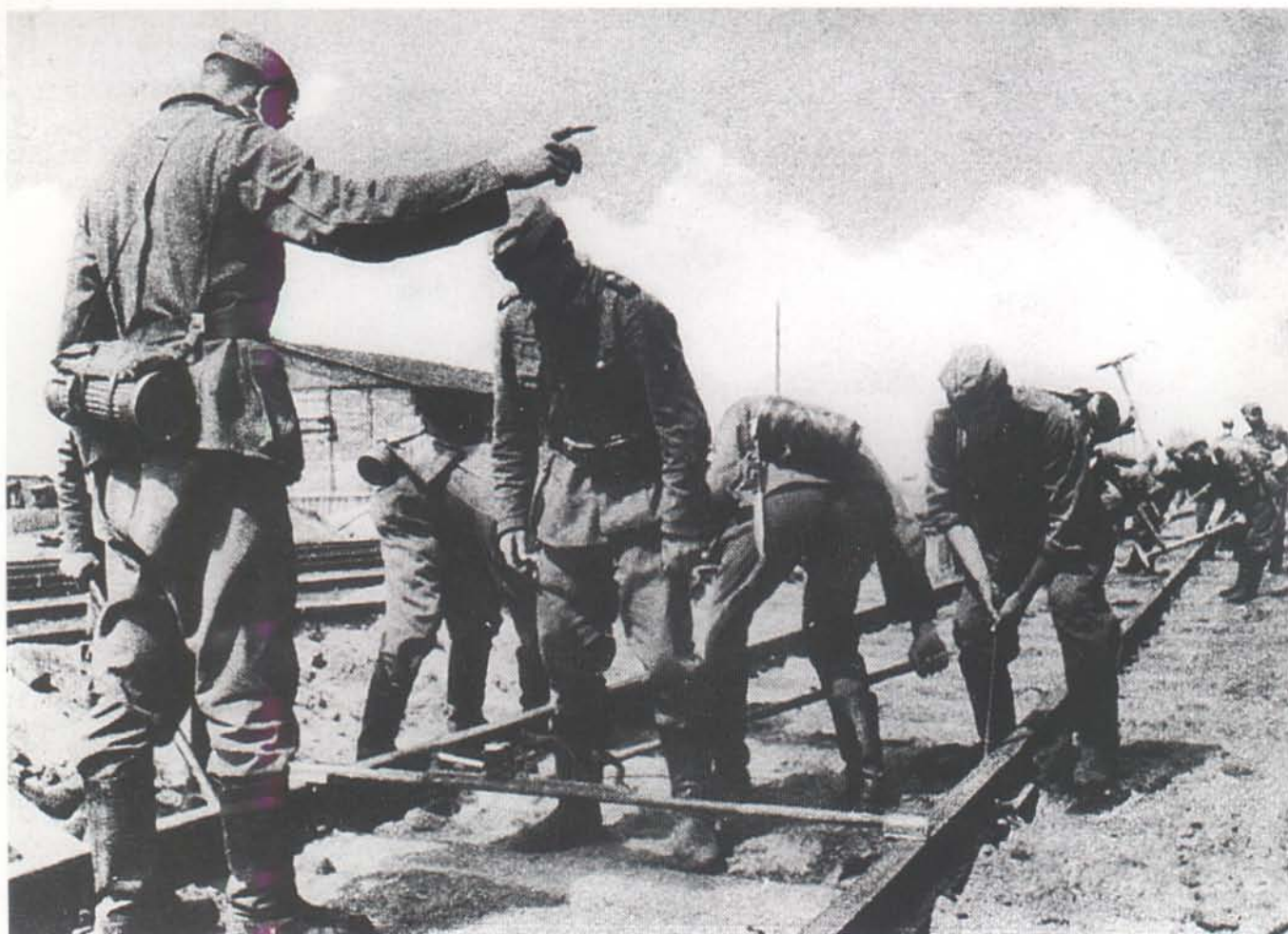
Unterschiedliche Spurweiten erfordern das Umnageln hunderter Kilometer Eisenbahngleis durch die Eisenbahnpioniere. Mit Spezialinstrumenten wird bei der Umnagelung der gleichmäßige Abstand der Schienen zu der kürzeren, russischen Spurweite gemessen.
