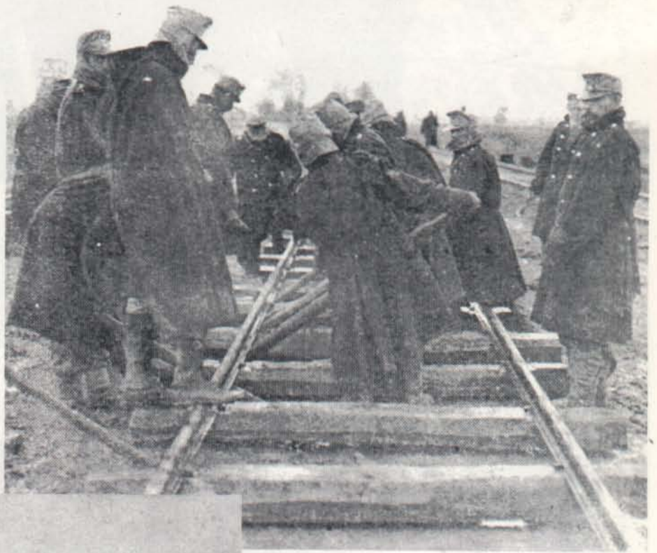
Rechts: Serbien 1915; Pioniere beim Bau eines Notgleises
