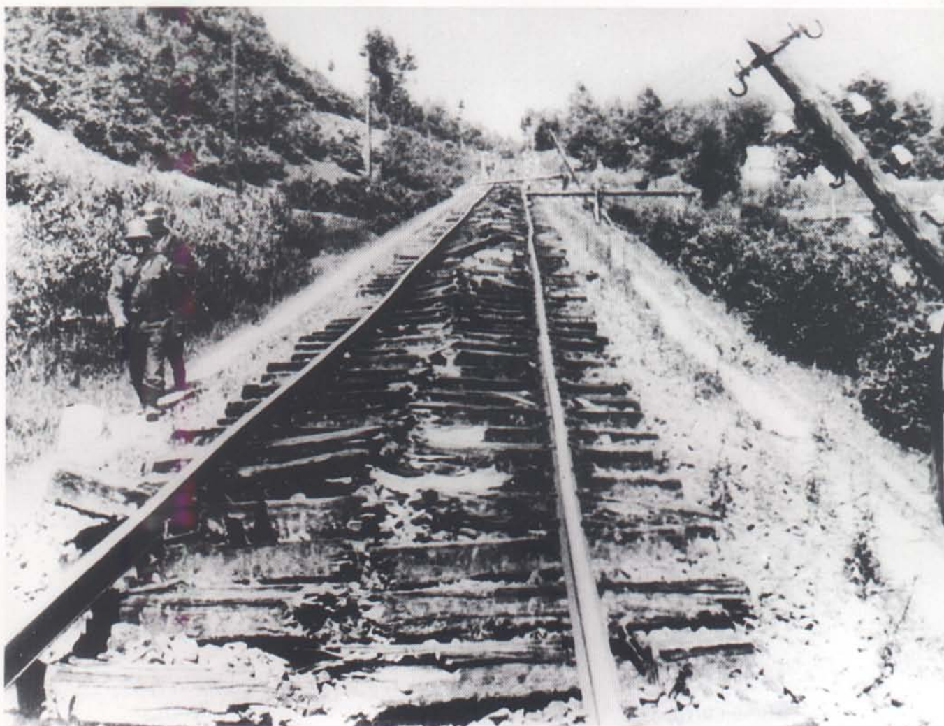
Wenn es die Aufgabe verlangte, hatten Eisenbahnpioniere auch Sperraufgaben zu erfüllen. Das Bild zeigt ein Eisenbahngleis nach dem Einsatz eines Schwellenpfluges. Zusätzlich wurden die Schienen gesprengt.
