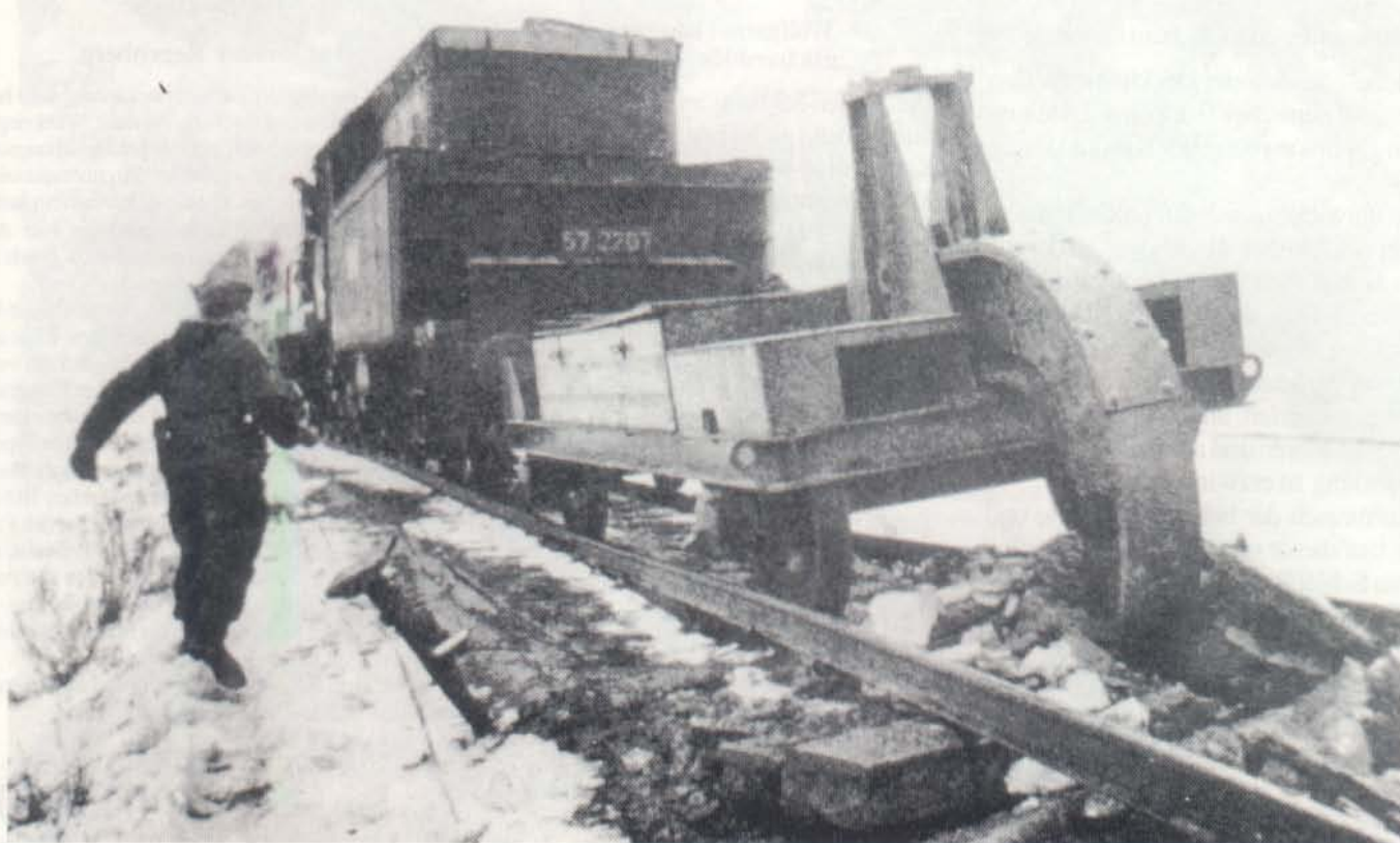
Als die Rückzugsbewegung und damit die Zerstörung von Eisenbahngleisen größere Ausmaße annahm, gab man besondere Geräte, die "Schienewölfe", in Auftrag. Von einer Lok gezogen riß das Gerät die Schienen aus der Verankerung und zerbrach die Schwellen. Zusätzlich wurden die Gleise in bestimmten Abständen gesprengt.
