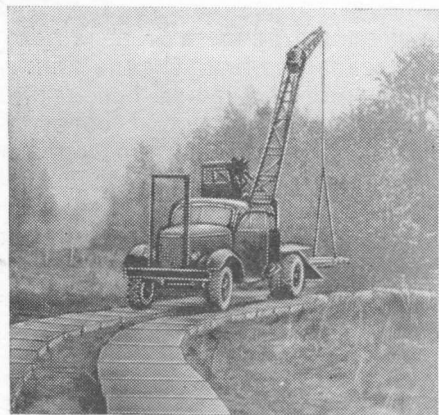
Рис. 18. Укладка железобетонных плит автокраном
