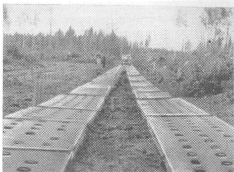
Рис. 15. Ус с покрытием из решетчатых железобетонных плит
