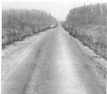
Рис. 37. Общий вид уса на хворостяной выстилке с засыпкой гравийным материалом
