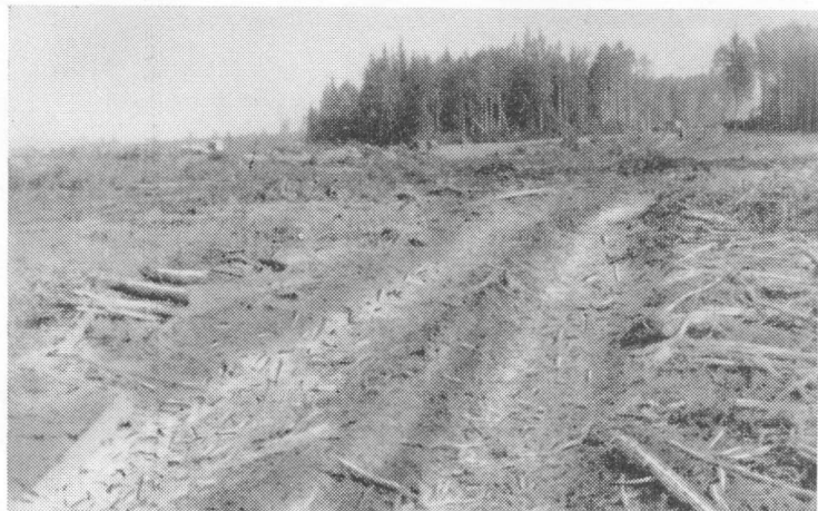
Рис. 33. Общий вид уса с хворостяной выстилкой
