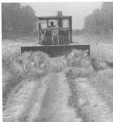
Рис. 45. Нарезка колеи колеенарезателем
