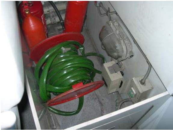
Расположение пожарного рукава в нише
