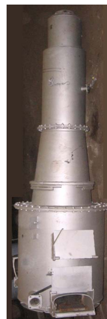
Рис. 7.3. Отопительный котел без расширительного бака.
