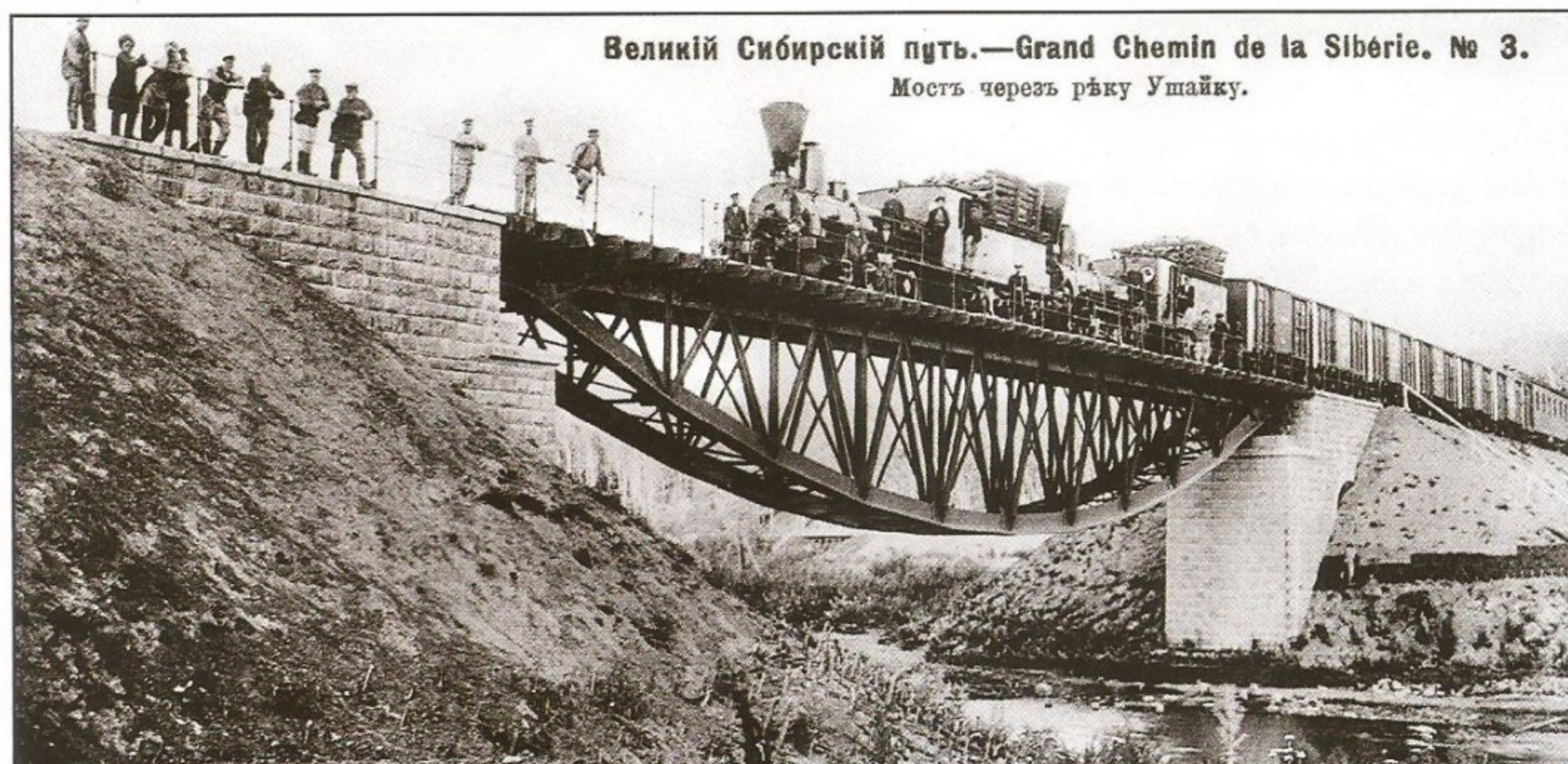
◀ Испытание моста через р. Ушайку на Транссибирской железной дороге. Фотография 1901 г.
