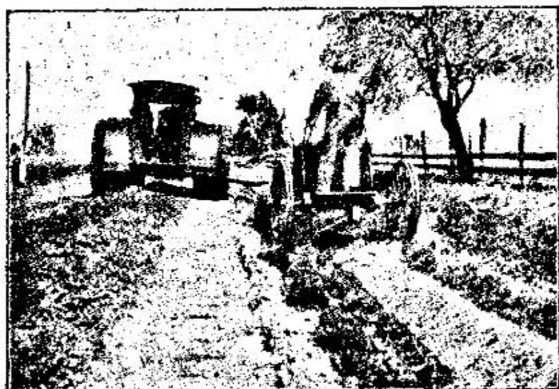
Рис. 78. Трактор тянет скребок (выборка кювета).
