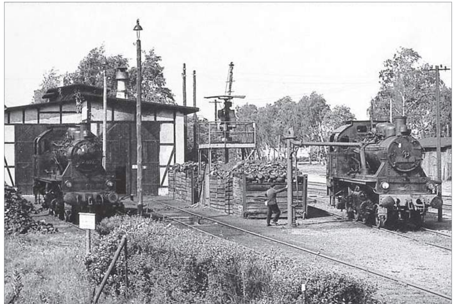
Hochbetrieb im Lokbahnhof Graal-Müritz am Endpunkt der einstigen Mecklenburgischen Bäderbahn. Wie man sieht, nutzte auch die Deutsche Reichsbahn noch die großzügig gestaltete Bekohlungsanlage mit dem elektromotorischen Kohlekrane. Foto: Günter Fiebig
