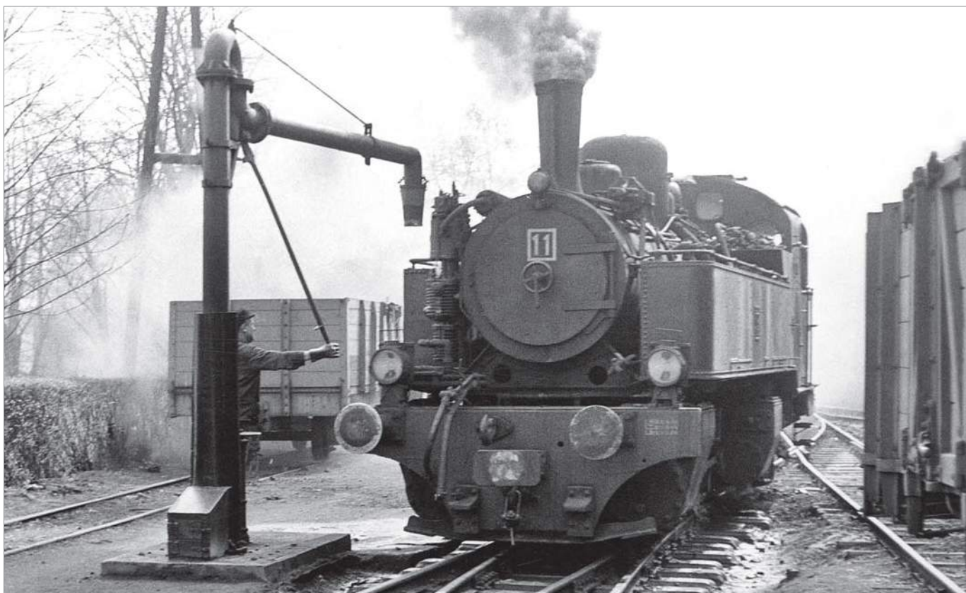
Brohl 1965: Mit gut gefülltem, seitlichem Kohlekasten rollt die BEG-Lok 11 an den Wasserkran, dessen Ausleger der Heizer über die Öffnung des Wasserkastens schwenkt. Foto: Dipl.-Ing. Herbert Stemmler
