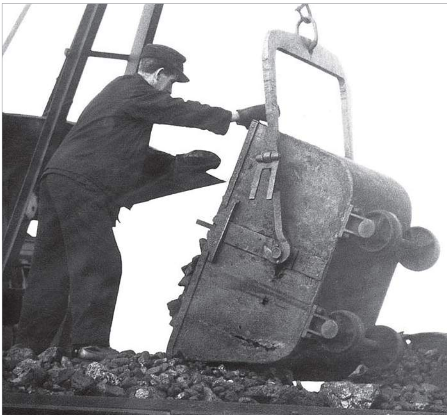
Nicht ungefährlich: Entleerung eines Bekohlungshunts durch Drehung über eine Achse, an deren Stützen die Haken des Säulendrehkrans angreifen. Foto: Foto Zeug, Trier
