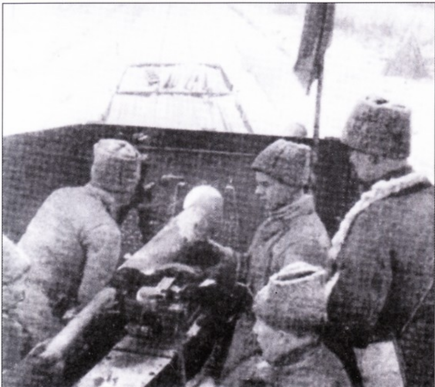
Импровизированные бронепоезда часто оборудовались полевой пушкой расположенной впереди состава.
