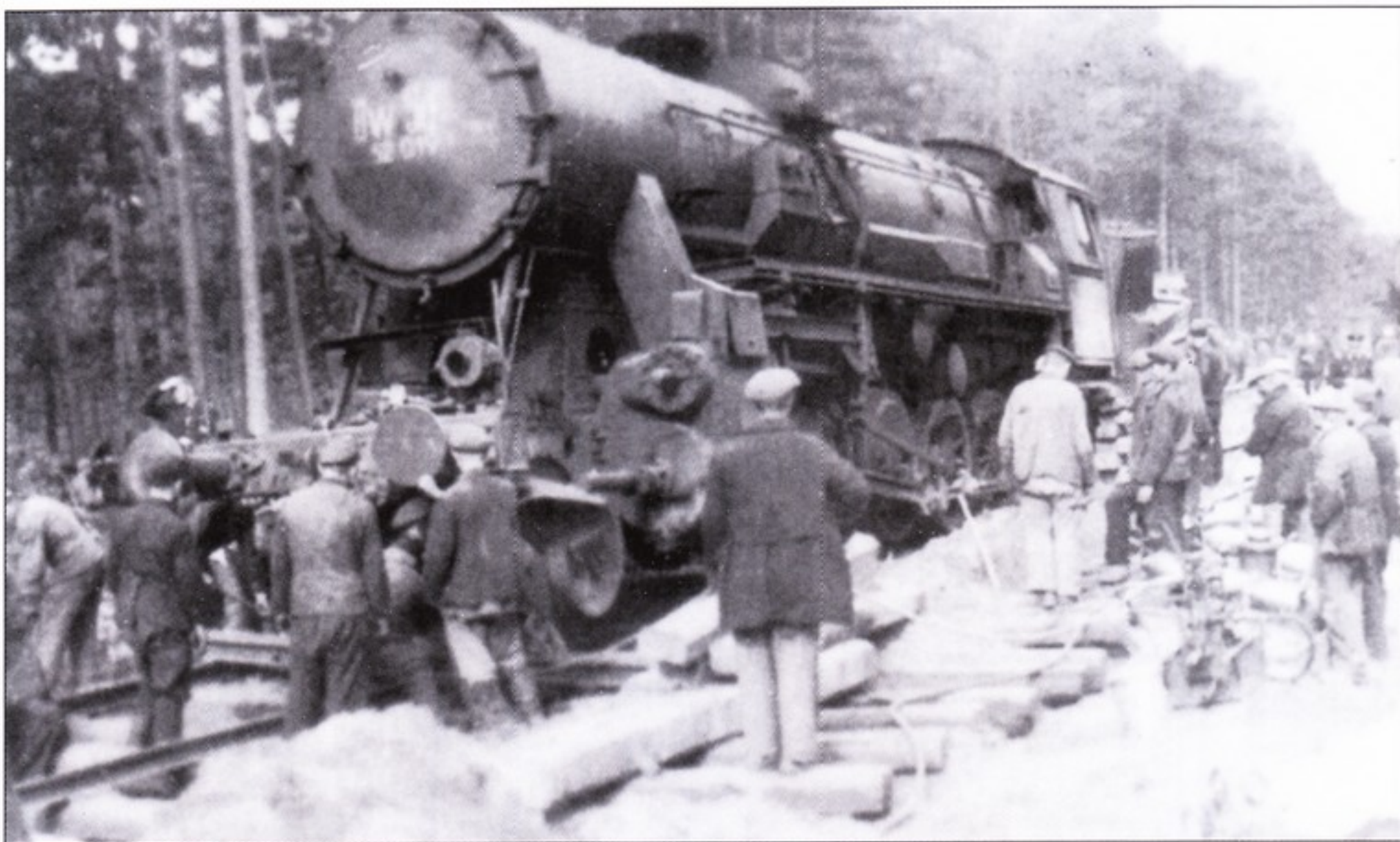
Рабочие бригады устанавливают паровоз № 52 019 на рельсы.
