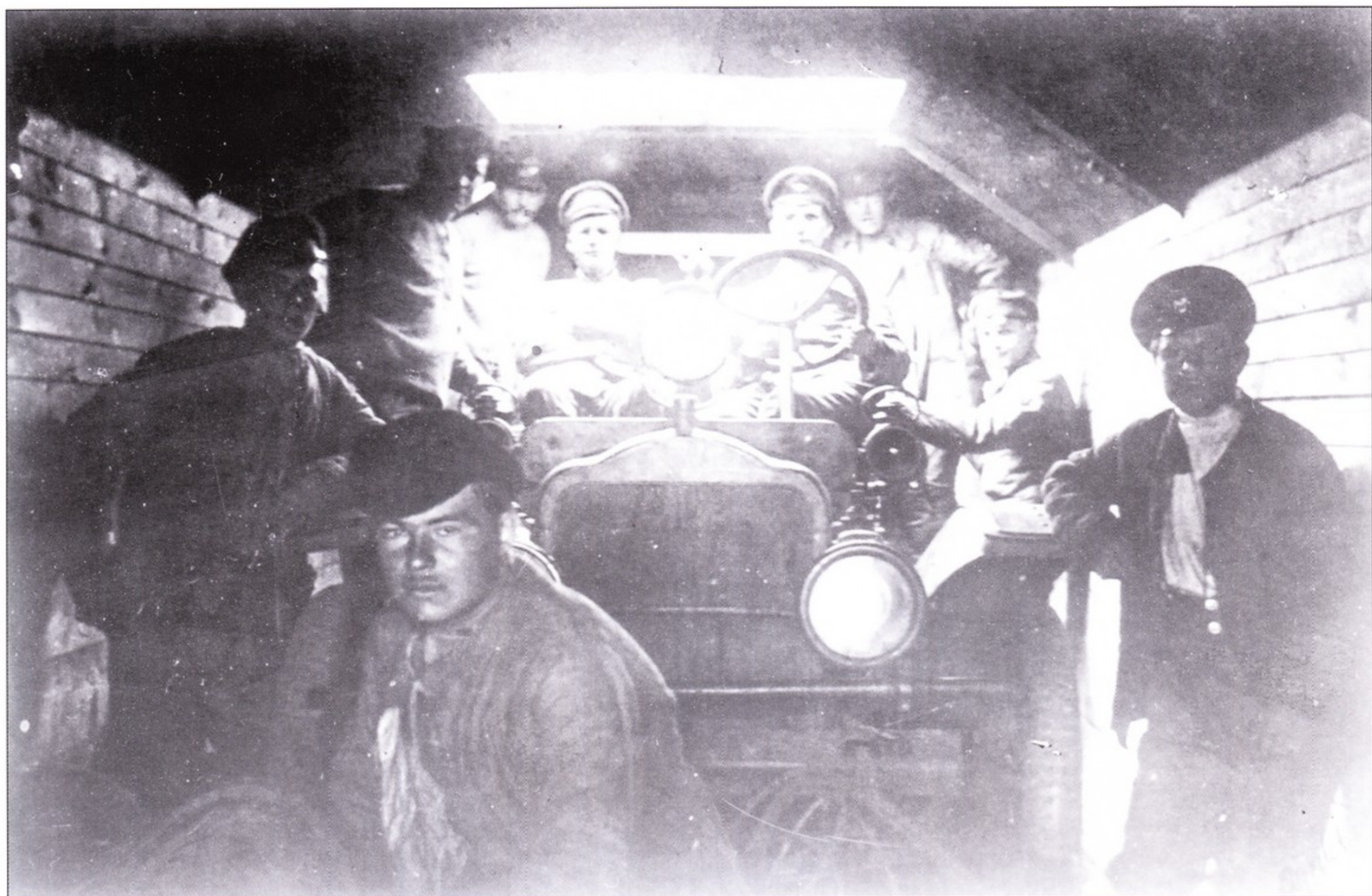
Воздухоплавательная автолебедка внутри бронеплощадки 23-го воздухоплавательного отряда.
