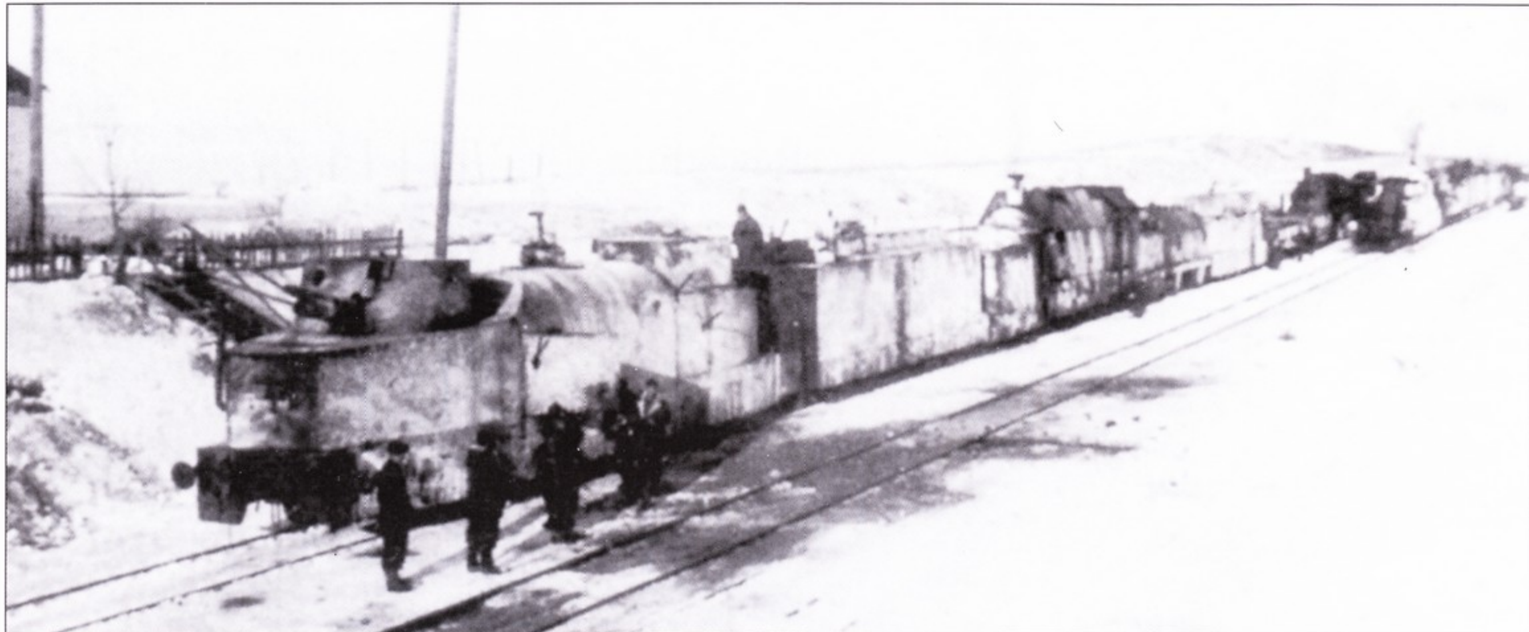
В сентябре 1939 года Советский Союз захватил несколько польских бронепоездов после оккупации восточной части Польши. Летом 1941 года они стали трофеем вермахта. Из двух таких бронепоездов сформировали немецкий бронепоезд PZ 10. На снимке бронепоезд Катрфзиг I на последней стадии формирования с немецким бронированным паровозом 57-й серии, командным и зенитными вагонами.
