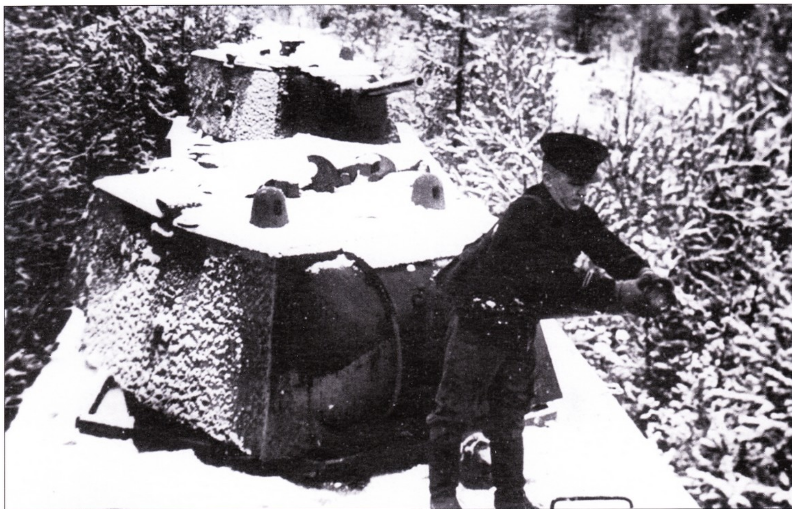
Броневагон с двумя башнями от тяжелого танка КВ-1 в составе бронепоезда Ленинградского фронта.
