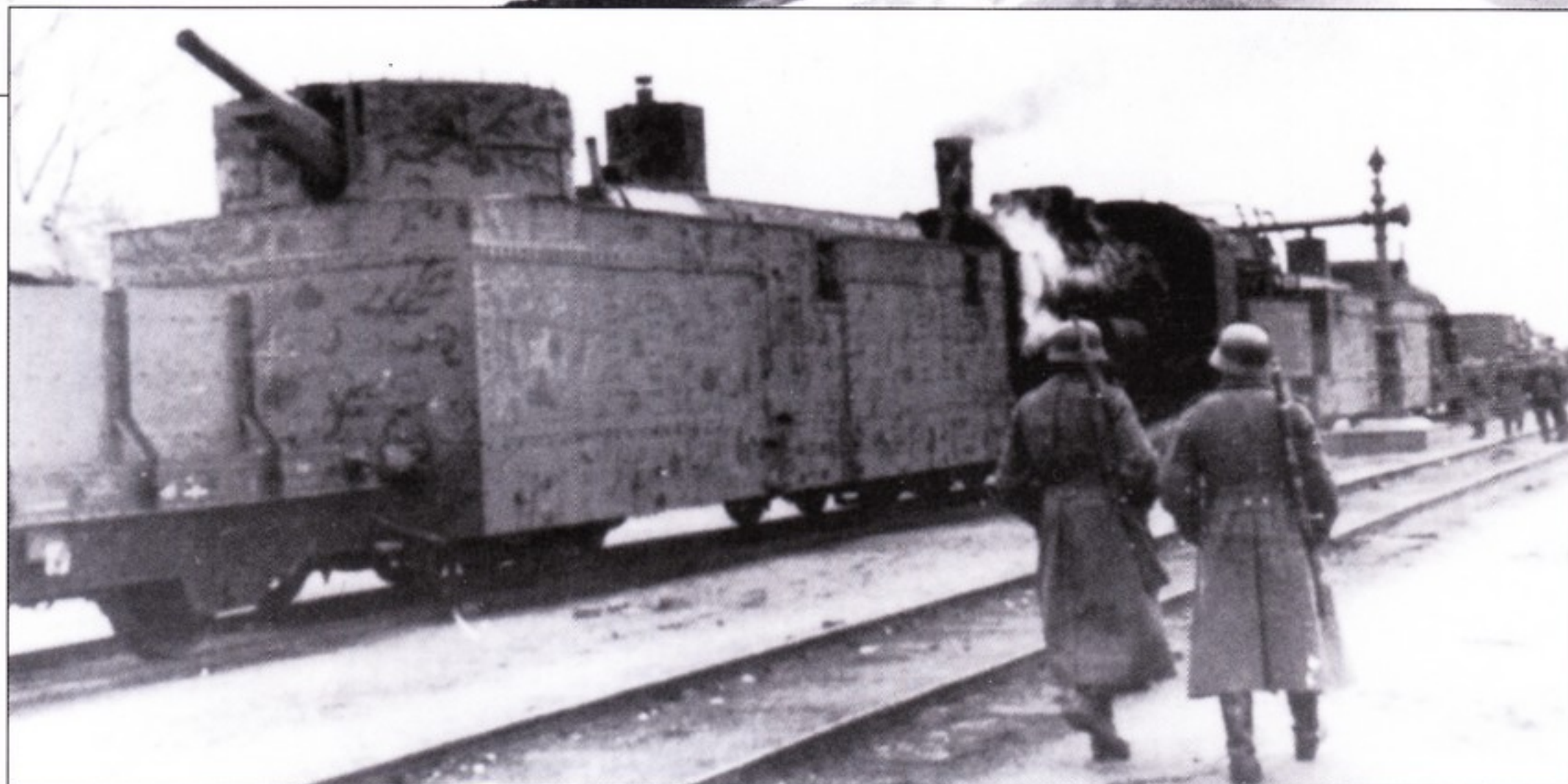
Трофейный советский броневоз вооружен одним 107-мм орудием. Он включен в состав советского бронепоезда № 28 осенью 1941 года.
