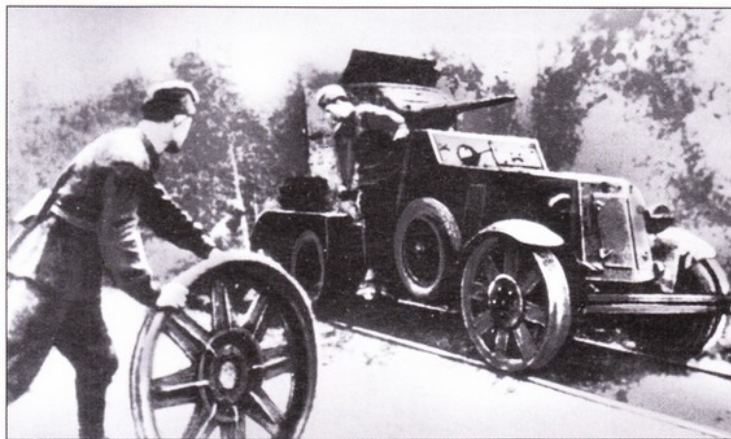
Броневедомитель Ба-10ЖД «переобувают» для езды по рельсам.
