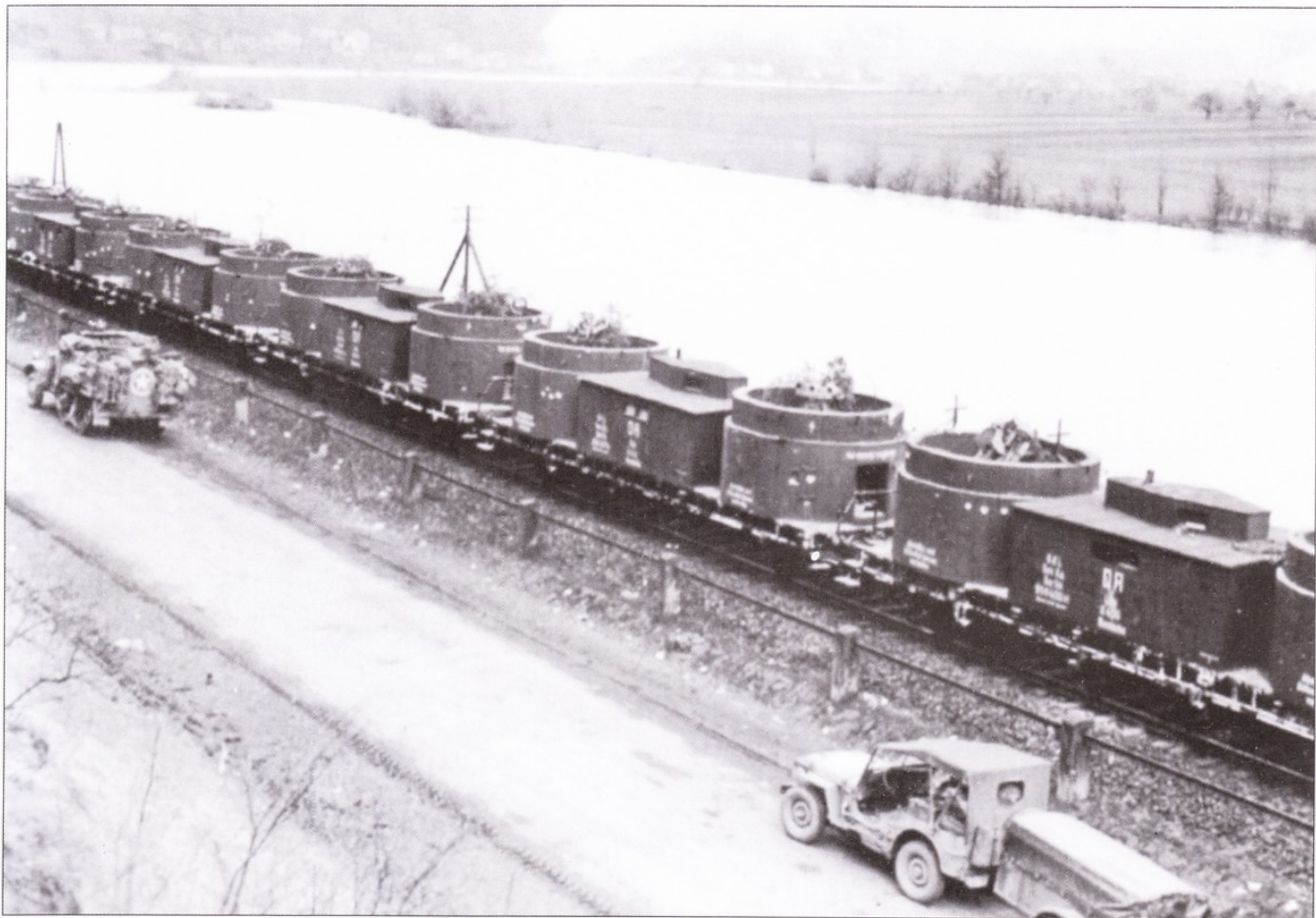
Немцы также строили зенитные бронепоезда для защиты железнодорожной сети от атак самолетов союзников. Они использовали пару усиленных бетоном кольцевых башен на каждом вагоне и различные типы зенитного оружия. На снимке: вооружение бронепоезда состоит из 30-мм трехствольного пулемета MG151 в каждой башне. Поезд захвачен американской армией около город Лагенпроцельтен на реке Майн севернее Вюрсбурга в начале апреля 1945 года.
