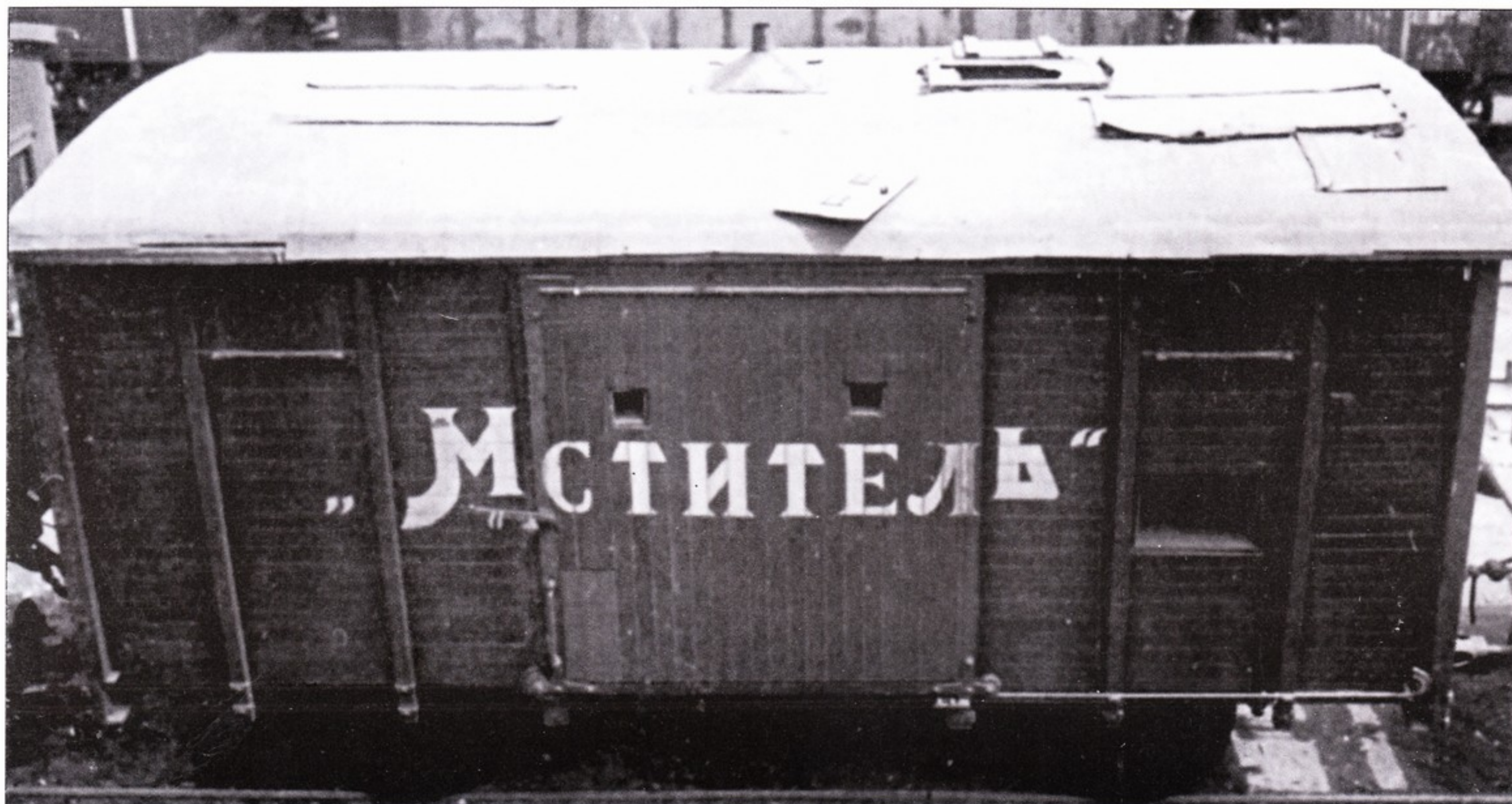
Для бронирования обычно использовались бронелисты. Другим способом защиты стали сооружения из бетона, когда он заливался между двумя деревянными стенками. Такой бетонный колпак представляет вагон белогвардейского бронепоезда Мститель. Снимок сделан во Владивостоке в январе 1919 года. 25 октября 1922 года его захватила Красная армия.
