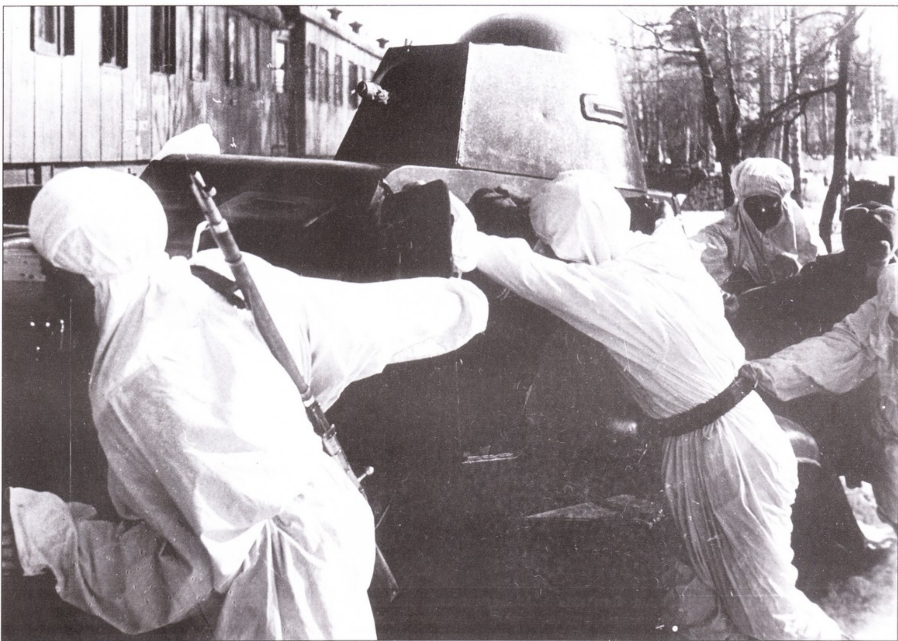
Установка бронеавтомобиля на рельсы после установки металлических колес.
