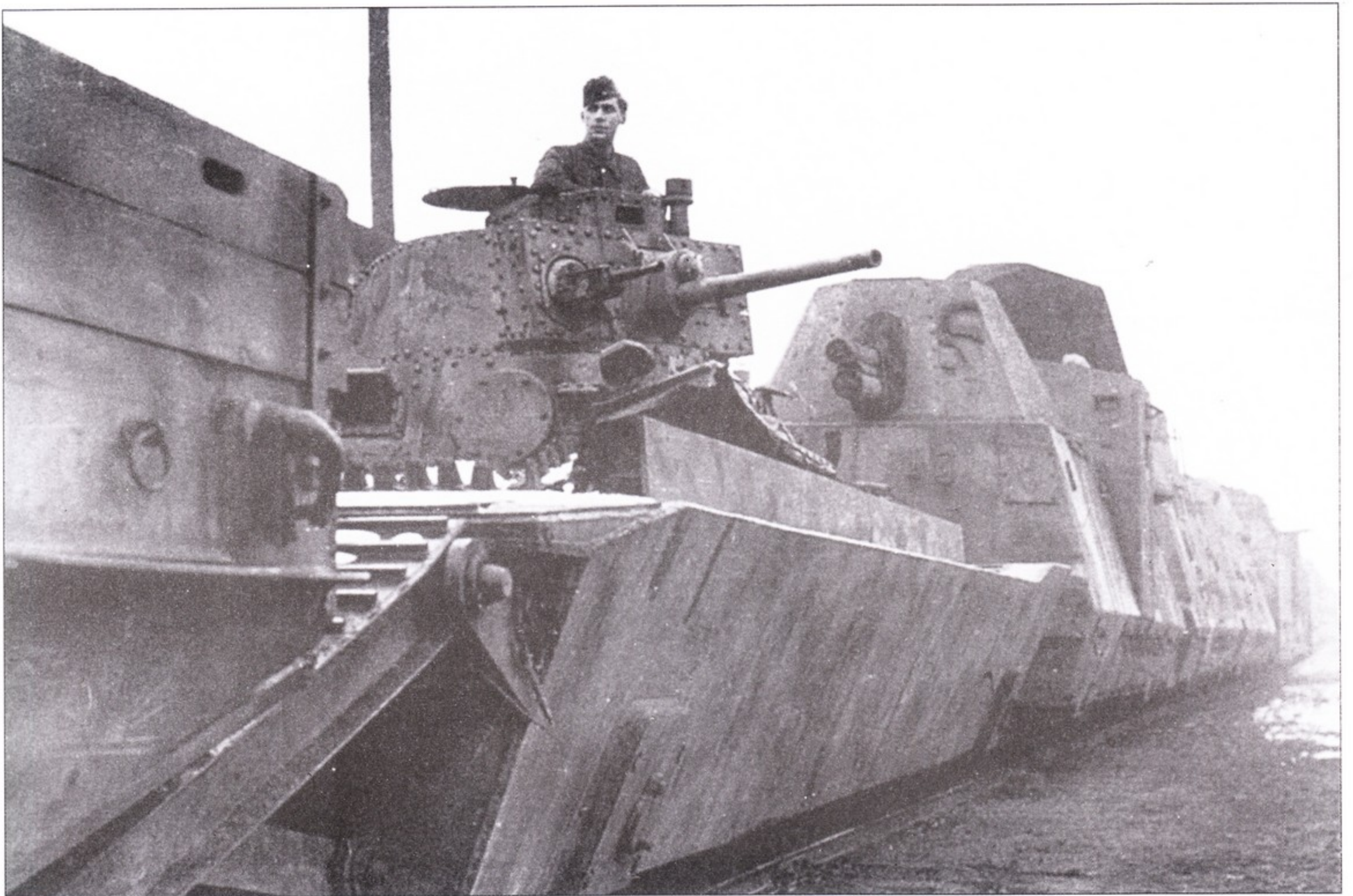
Фотография бронепоезда № 63. Пулемет из корпуса танка Pz.Kpfw. 38(t) демонтирован. Хорошо видна часть рампы, предназначенной для схода танка с платформы.
