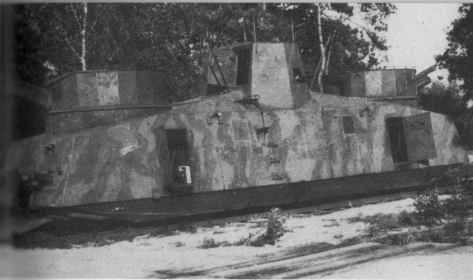
Unten: Italienischer Bauart (Ansaldo) waren die vierachsigen, zweimotorigen Triebwagen Nr. 30 – 38. Die Hauptbewaffnung waren zwei Türme des Panzers M 13/40 mit einer 4,7-cm-KwK. (KR)
