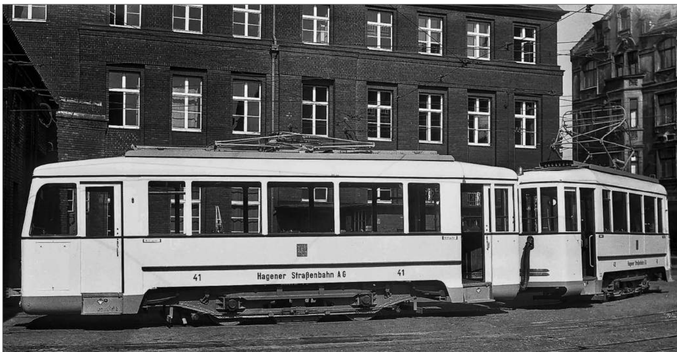
Einer der beiden auf alte Fahrgestelle aufgebauten Zwillingstriebwagen kurz nach seiner Fertigstellung 1953 im Betriebsbahnhof Wehringhausen
