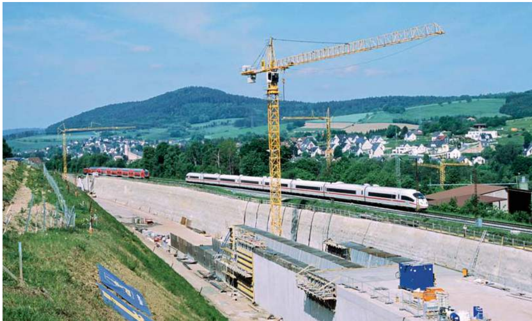
Bei Hain begegnet 403 073 als ICE 724 dem bergwärts fahrenden RE 4611 im Bereich des in offener Bauweise entstehenden „Tunnels Hain“. Dessen Westportal entsteht im Bereich der schiebenden 111. In der Baugrube laufen Betonier-Arbeiten an Sohle, Wänden und Decke.
