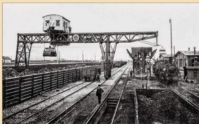
Der querfahrende Greiferkran auf einer fahrbaren Fachwerkbrücke belud in Leipzig-Wahren den feststehenden Kohleabgabebunker.
