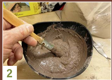
2 Die Spachtelmasse wird entsprechend der beiliegenden Anleitung in einem flexiblen Gipsbecher mit Wasser sämig angerührt.
