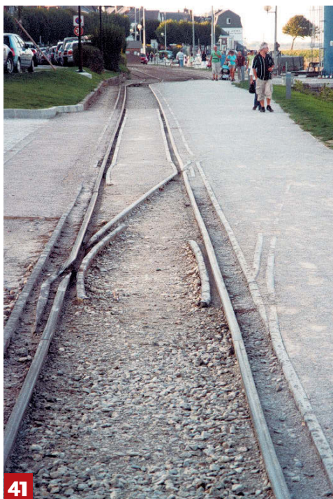
41 - Branchement avec voie métrique et voie normale mêlées à Saint-Valéry-sur-Somme (80).
