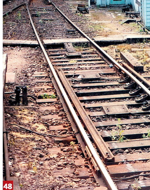
48 - Aiguille de déraillement en gare de Rouen RD (76).
