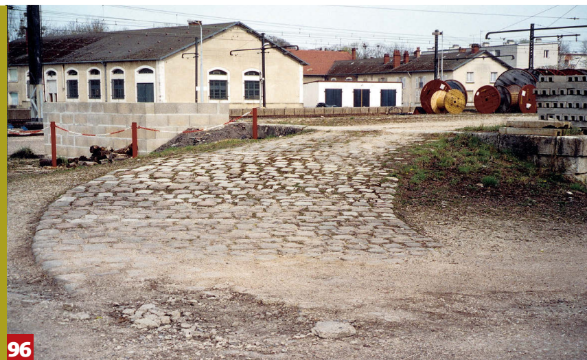
96 - À Tonnerre (89), le plan incliné permettant l'accès au quai à marchandises est pavé et tourne à 90°. On remarque l'occupation actuelle du quai par l'Équipement.
