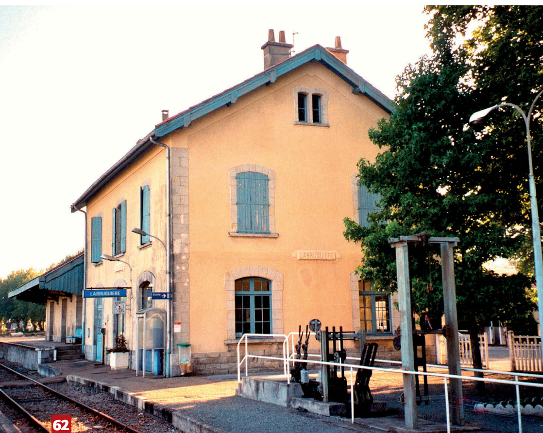
62 - À Labruguière (81), les installations extérieures de sécurité sont placées à proximité du BV.
