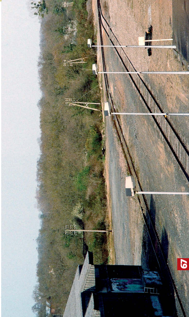
67 - Les installations de la gare de Montaignu (85) sont établies de chaque côté de la double voie. Les voies marchandises sont accessibles par refoulement.
