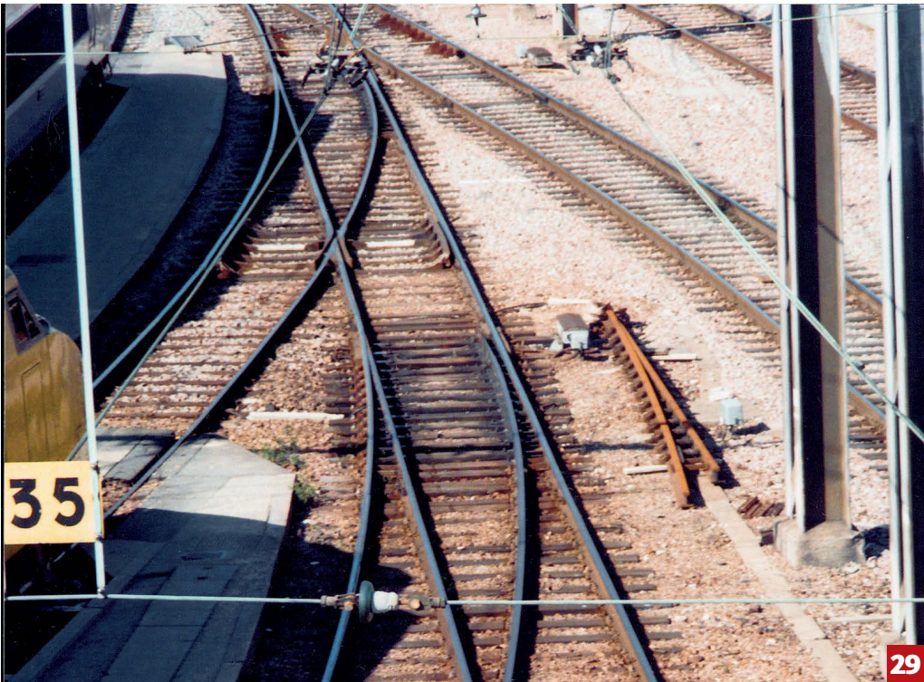
29 - Deux aiguillages à droite dans les emprises TGV de Paris-Bercy (94).
