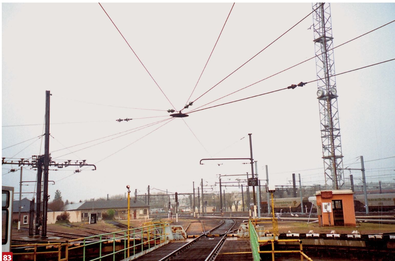
83 - Les ponts tournants sont très facilement électrifiables, comme c'est le cas au dépôt de Laroche-Migennes (89).
