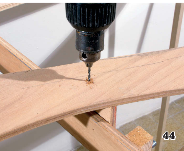
44 - Le préperçage dans l'épaisseur du contreplaqué est indispensable.
