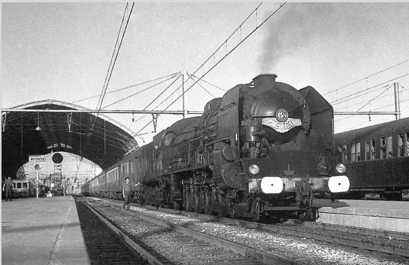
La 241 P 6 (modèle reproduit par Jouef), assure le relais d'une machine électrique, en gare d'Avignon, en 1959 ou 1960. Notez les tampons bien blancs, et le disque rouge replié entre les feux, détail caractéristique des « 2 P » marseillaises. (Photo Long, coll. LR Presse)
