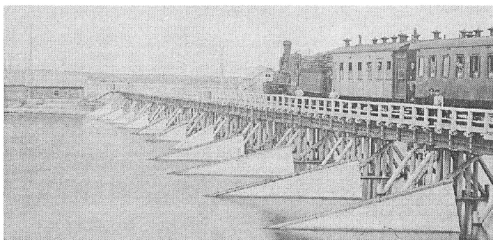
Усиленные ледорезы железнодорожного моста через р. Шуя
