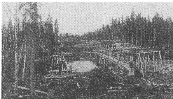
Прокладка железной дороги по болоту на участке Сорока – Кемь
