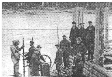
Водолазные работы при возведении моста на Мурманской магистрали
