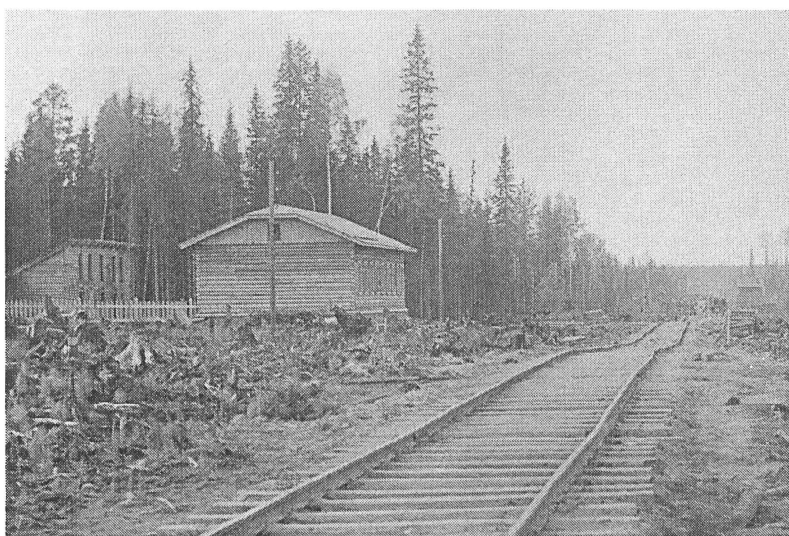
Неровности пути на станции Ладва
