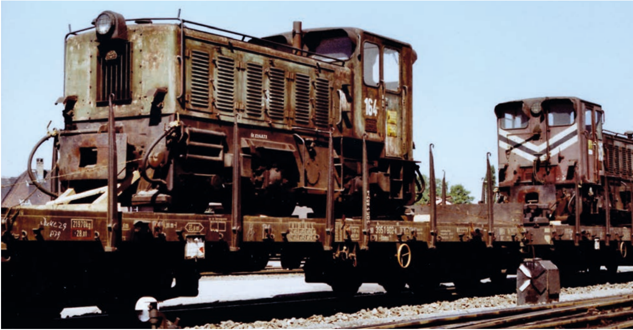
Zwei Schmalspurdieselloks auf dem Weg nach Italien 1974. Bei gebrauchten Fahrzeugen wie diesen beschränkt sich der Sicherungsaufwand auf Holzunterlagen und Kanthölzer für die Radsätze, je eine einfache Stützkonstruktion aus Holz vorne und hinten sowie diagonale Drahtverspannungen.
