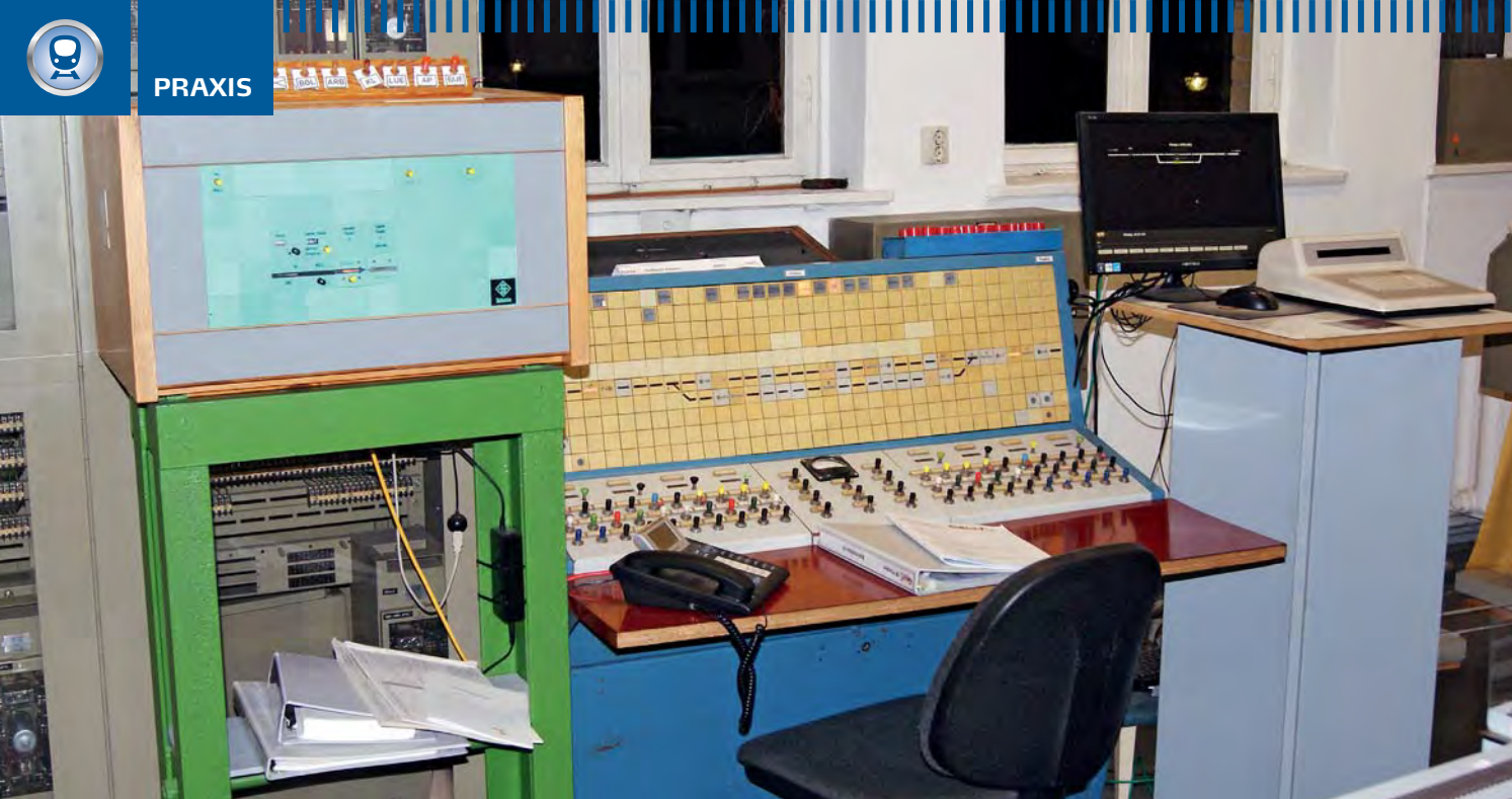
Arbeitsplatz des Fahrdienstleiters Pörsten im EBUf. Links befindet sich das WSSB-Pult für den Relais-Block. In der Mitte steht das EZMG-Pult mit der charakteristischen Meldetafel. Rechts befindet sich die Zugnummernmeldeanlage mit ihrem Eingabegerät.
