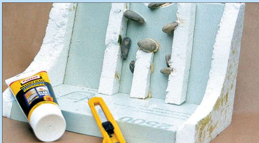
Die Grundform des Dioramas wurde aus Styrodur und Styropor mit Montagekleber verleimt. Die Wasserfallrinne ist bereits zu erkennen. Rundgeschliffene Felsen sollen später das Wasser in Bahnen lenken.
