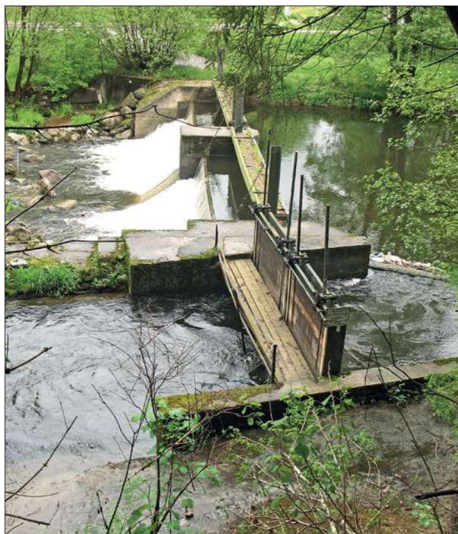
Überfallwehr (oben Mitte) und bewegliches Stauwehr nebeneinander. Die Anlage hat zudem einen Niedrigwasserablauf (oben) und eine Kanu- oder Fischrinne (vorne). Bei ausreichenden Niederschlägen läuft das aufgestaute (und damit regulierte) Wasser über die beiden Schwellen in der Mitte ab. Fotos: Horst Meier
