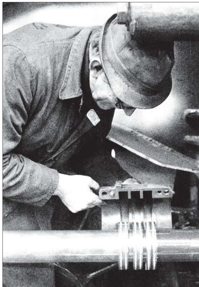
Auf die Kolbendichtungsringe wird das zweiteilige Stopfbuchsengehäuse aufgesetzt.
