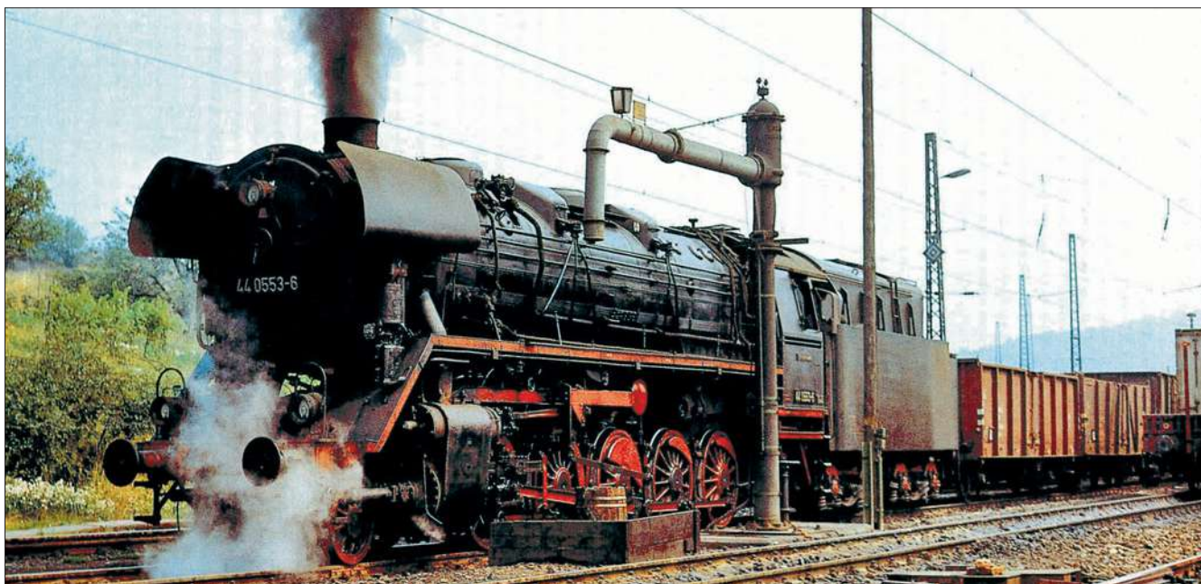
Die Deutsche Reichsbahn in der DDR baute zwischen 1959 und 1967 insgesamt 94 Lokomotiven der Baureihe 44 auf Ölhauptfeuerung um, darunter auch die 44 0553.
