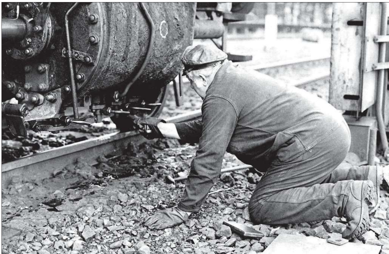
An einer Lok der Baureihe 44 werden bei einer Probefahrt die Zylinderventile überprüft (Zylinderentwässerung).
