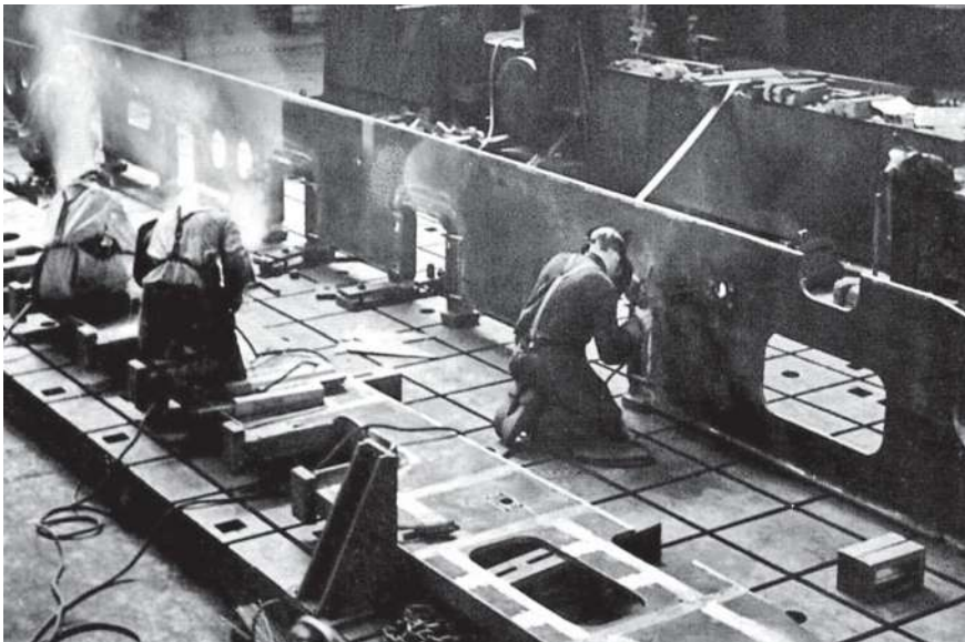
So entsteht ein geschweißter Blechrahmen. Beide Rahmenhälften sind gerade in Bearbeitung.
