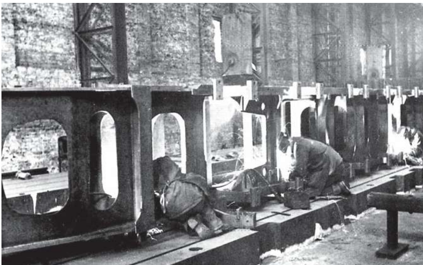
Nun werden die unteren Versteifungsbleche an den Rahmen geschweißt.
