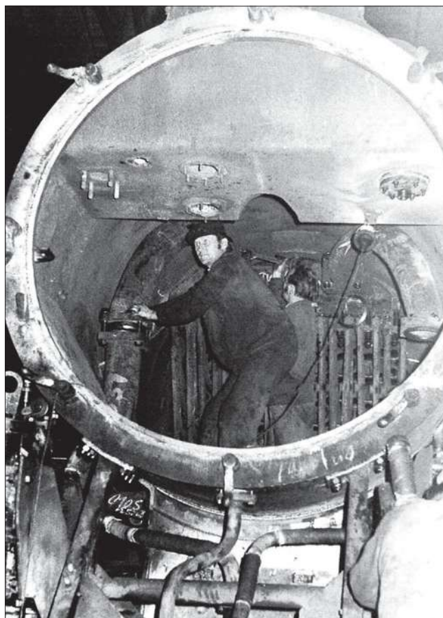
Einbau der Einströmröhre und der Überhitzereinheiten bei einer Lok der Baureihe 01 5 .
