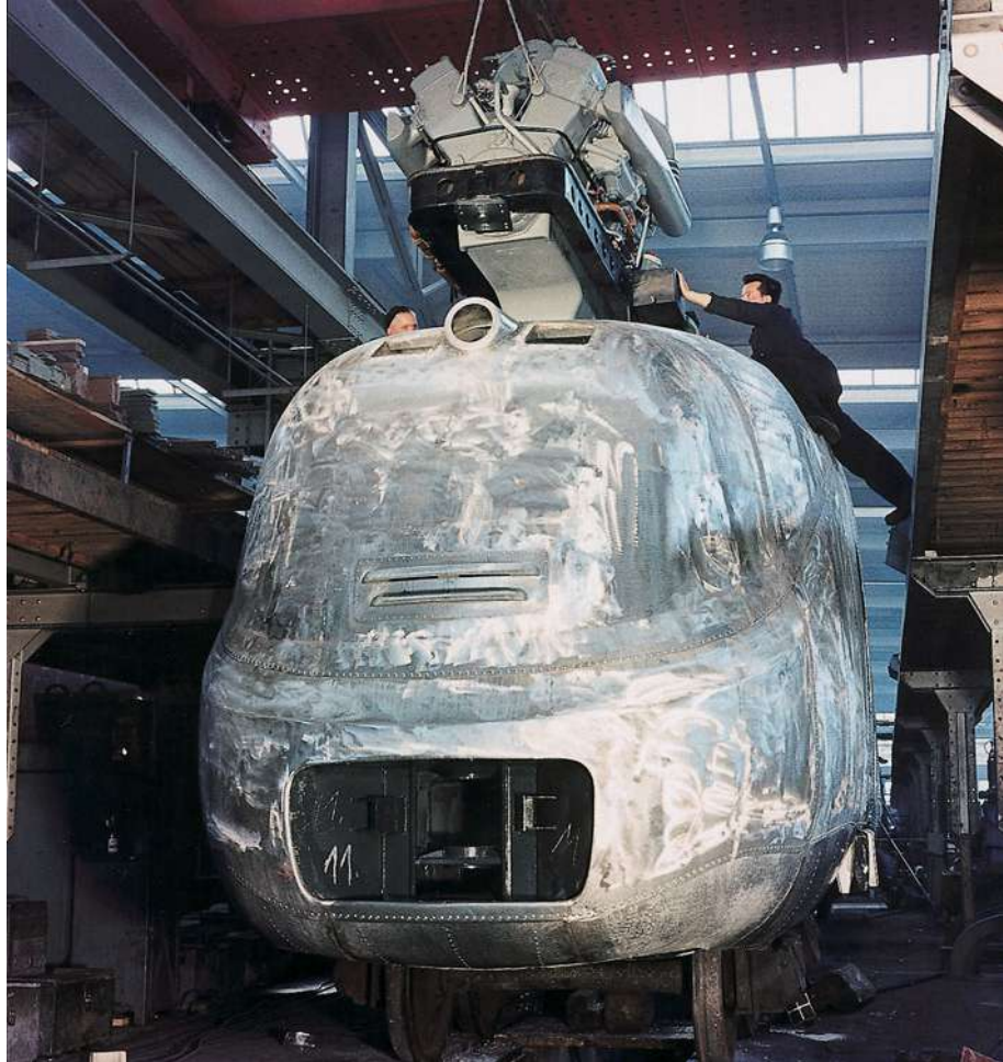
Einsetzen des Dieselmotors in den Maschinenraum im Vorbau des Maschinenwagens mittels eines Krans durch eine Dachöffnung. Zum Einbau gelangten drei verschiedene Motoren mit Aufladeturbinen folgender Hersteller: Daimler-Benz, MAN und Maybach.
