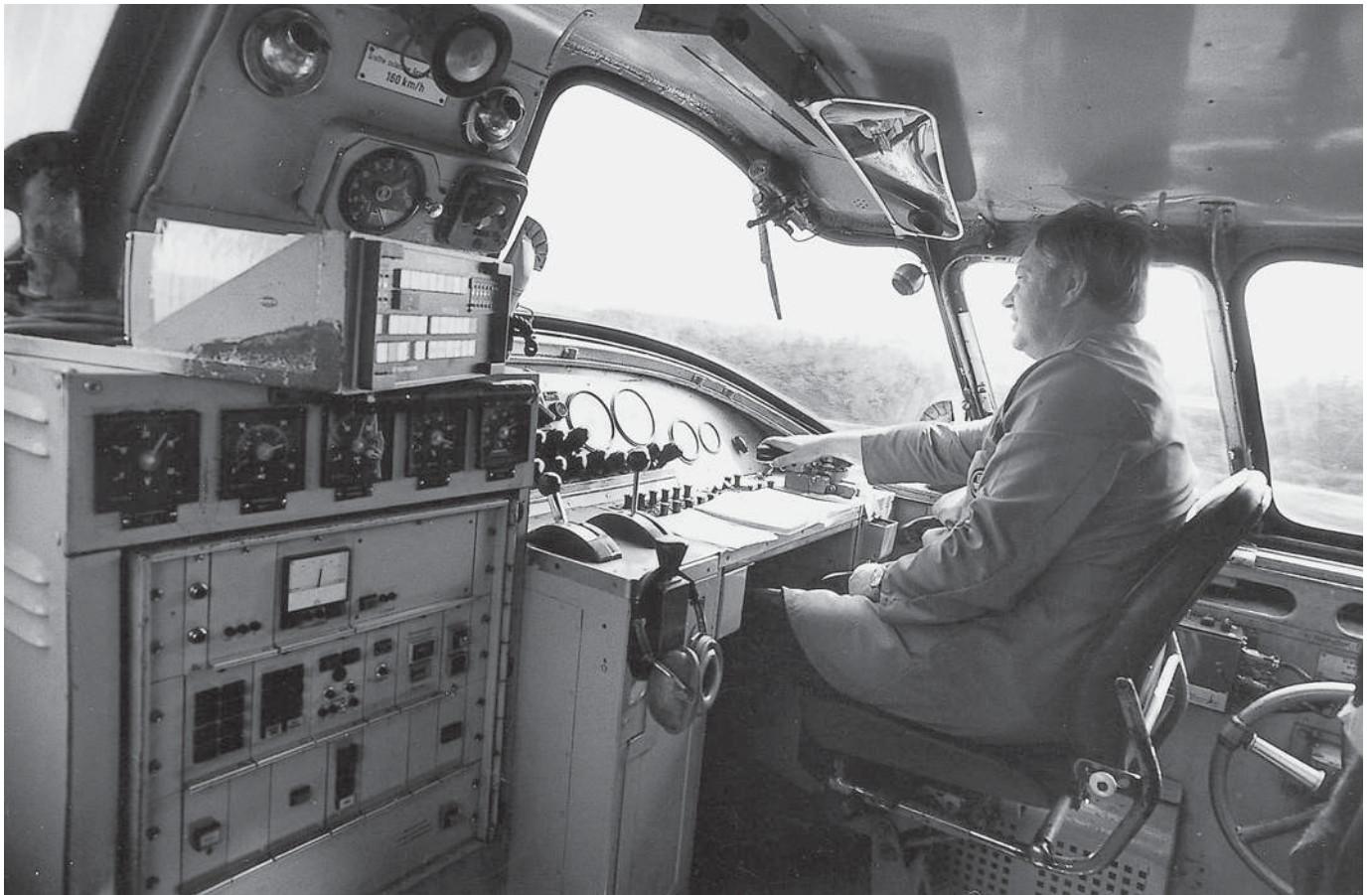
In der Führerkabine des 602 002 (18. Mai 1978). Vorne links befindet sich der Steuer- schrank für die Gasturbine. Foto: DB (BD HAMBURG/CHLOUBA)
