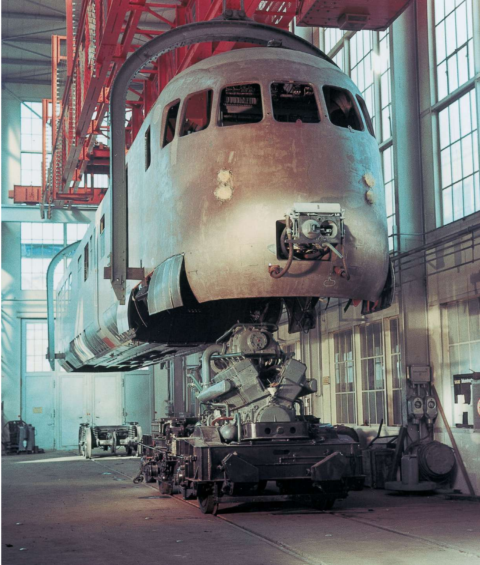
Aufsetzen eines VT 08.5-Wagenkastens auf die Drehgestelle im Werk Nürnberg der Maschinenfabrik Augsburg-Nürnberg AG im April 1952. MAN baute in den Jahren 1952 bis 1954 insgesamt 13 Exemplare VT 08.5, Düwag 7 Stück. Die 22 Mittelwagen VM 08.5 entstanden alle bei der Waggon- und Maschinenfabrik Donauwörth, die Steuerwagen VS 08.5 wurden von Rathgeber (7 Stück) sowie dem Verein Westdeutscher Waggonfabriken (6) geliefert. FOTOS: WERKARCHIV MAN-SCHIENENFAHRZEUGE (3)
