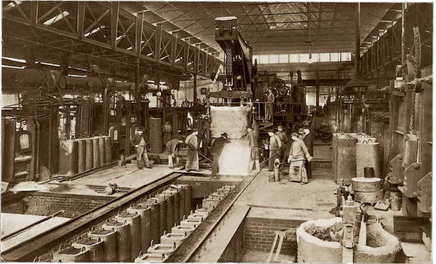
Kokillenguss im Krupp'schen Martinwerk I um 1910. Im Siemens-Martin-Ofen wurde sowohl Roheisen gefrischt als auch Alteisen umgeschmolzen.
