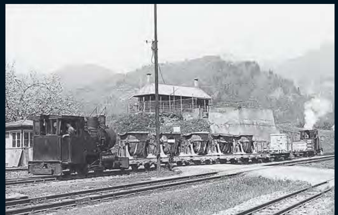
Schlacketransport auf der 760-mm-Werksbahn des Stahlwerks der Firma Böhler im steirischen Kapfenberg (1967). FOTOS: P. SCHMIED (2)
