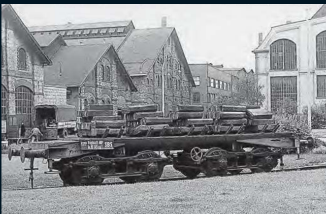
Halbzeuge (Knüppel) auf einem Flachwagen, der auf der Basis eines 52er-Wannentenders entstanden ist (SBS in Ternitz/Niederösterreich).
