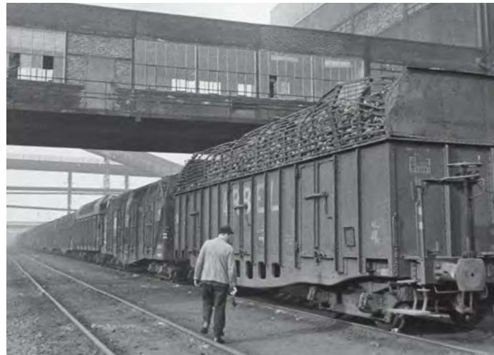
In Bochum-Langendreer wird um 1955 ein Koks zug für Frankreich abgefertigt. Beachtenswert ist der Aufbau der Wagen zur Erhöhung der Zuladung. FOTO: SLG. MEINHOLD
