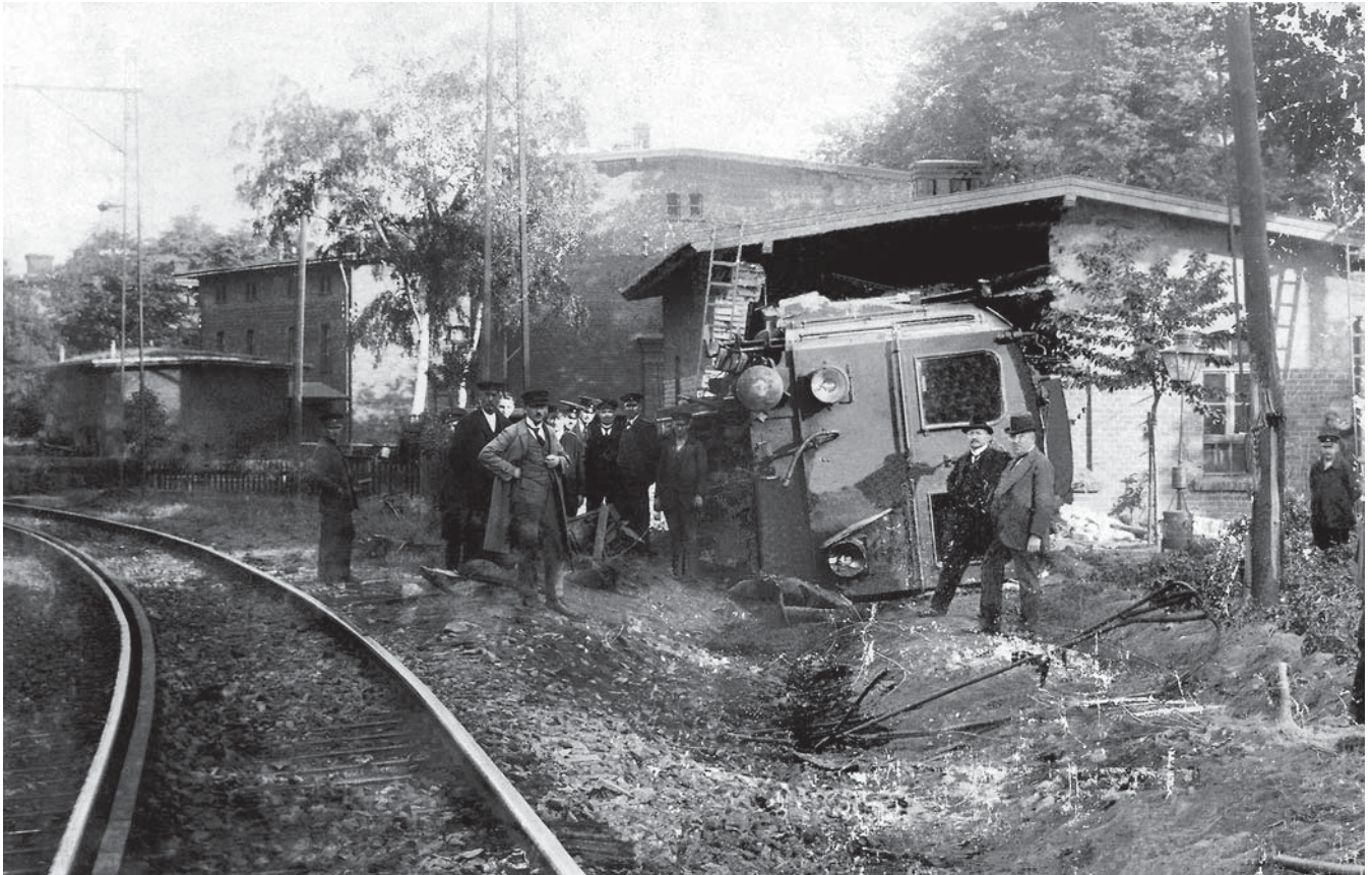
Am 8. Juni 1922 hatte die EP 207 in Dittersbach den D 191 bespannt. Bei der anschließenden Talfahrt versagten die Bremsen, und an der Einfahrt des Bf Waldenburg kippte in einem engen Gleisbogen die Lok aus dem Gleis, während der losgerissene Zug noch etwa 400 Meter bis in den Bahnhof hinein rollte. (Slg. Th. Scherrans)
