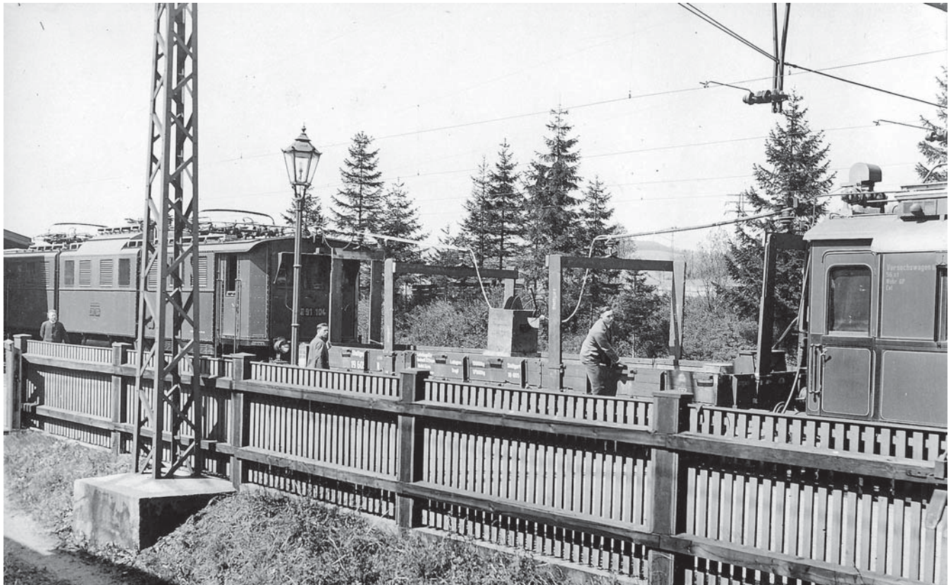
Ein auf einem Flachwagen isoliert aufgebauter Wasserwiderstand diente zur Leistungsuntersuchung der E-Bremse mit der E 91 104. (Nachlass E. W. Curtius, Slg. Chr. Tietze)
