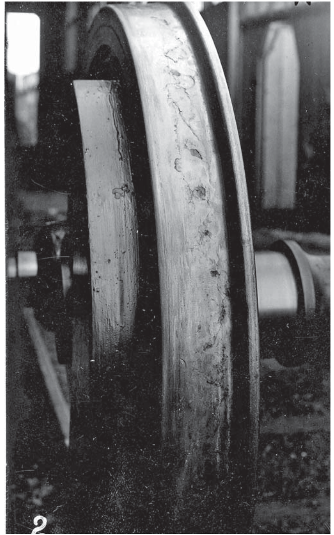
Ausbrüche in den Laufflächen der Radsätze erforderten deren Austausch. (Slg. Th. Borbe)
