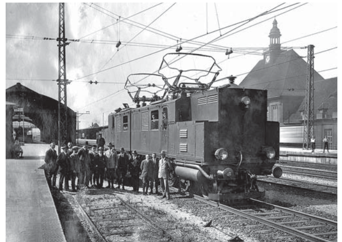
Am 15. August 1923 haben höhere Beamte der Rbd Breslau mit der EP 211/212 anlässlich der Abnahme der Fahrleitung von Lauban nach Görlitz die Bügelfahrt absolviert. (Werkfoto SSW, Slg. Chr. Tietze)
