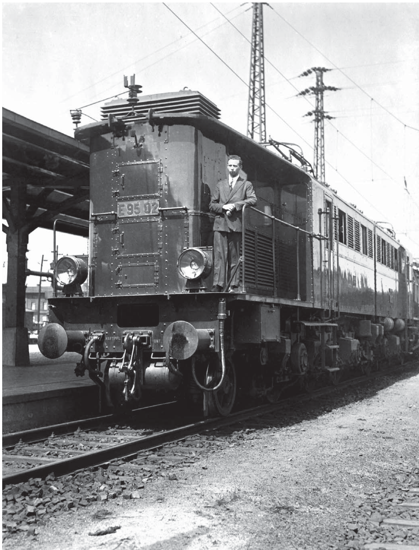
Aufnahme von einer Versuchsfahrt der mit Widerstandsbremse ausgerüsteten E 95 02 im Bf Königszell (Nachlass E. W. Curtius, Slg. Chr. Tietze)
