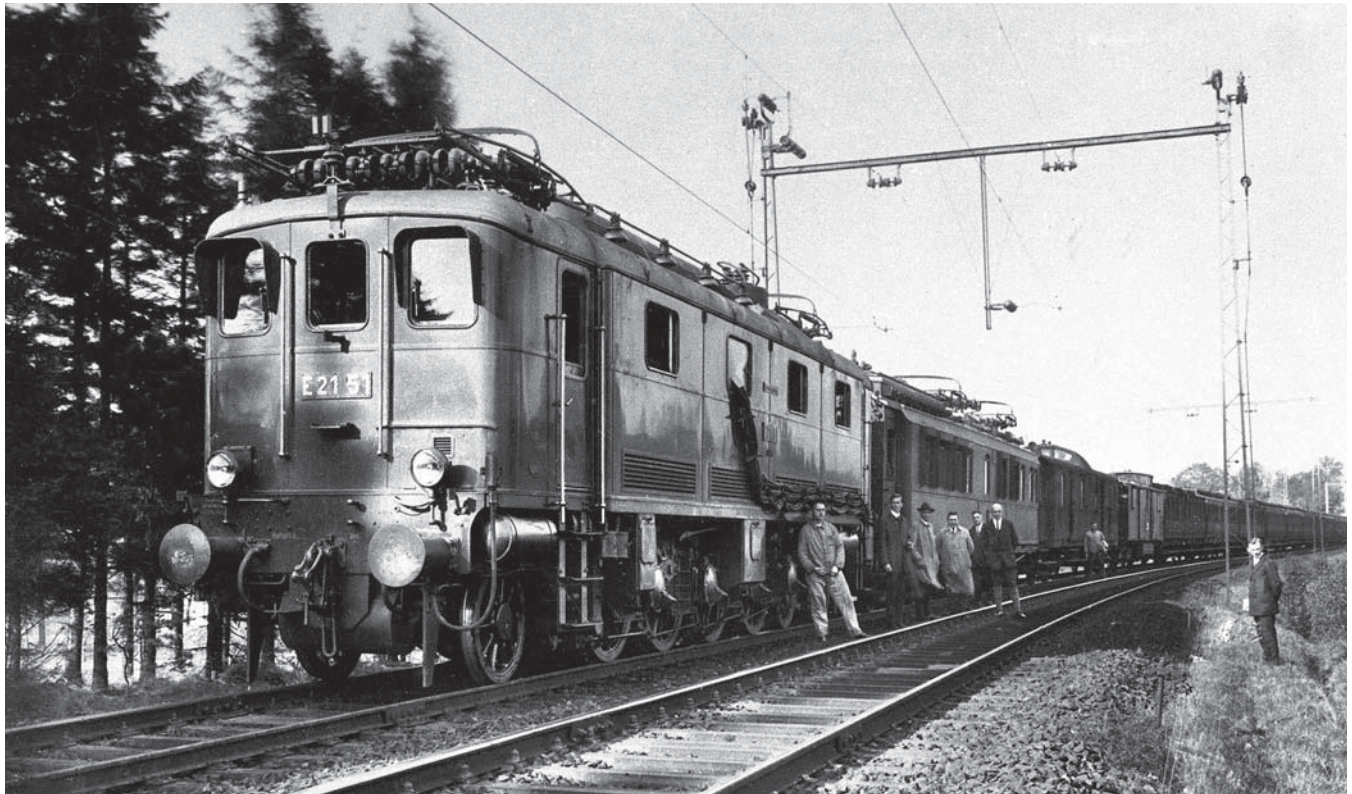
Die Abnahmeprüfungsfahrt mit einem 700 Tonnen schweren Reisezug musste bei Rabishau wegen eines Trafoschadens vorzeitig abgebrochen werden. (Slg. Th. Borbe)
