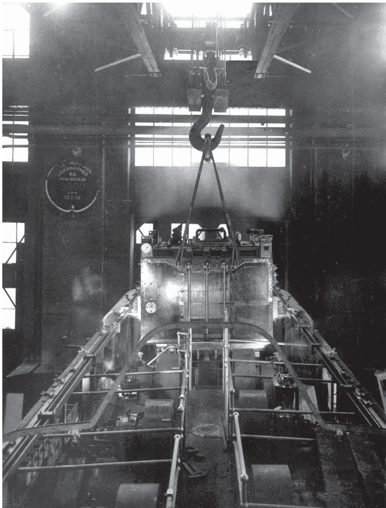
Einbau des Hauptumspanners. Gut zu erkennen sind der hochliegende Maschinenraumgang und die Kontur des darüber liegenden Dachaufbaus. (Werkfoto BEW, Slg. Th. Borbe)
