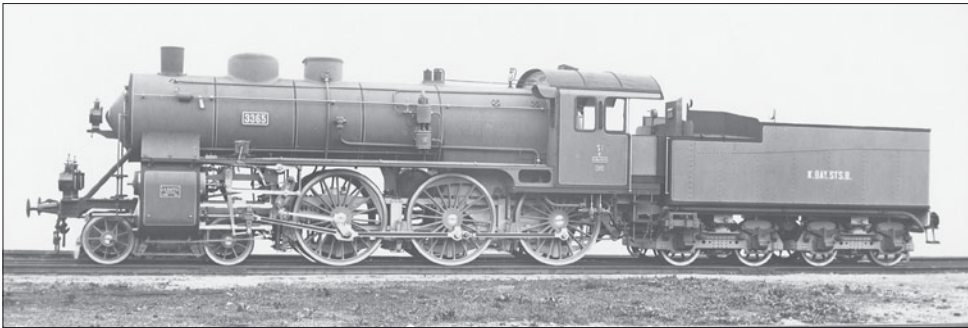
Bay. Sts. B.“ und Kesselschild am Führerhaus, Fabrikschild an der Zylinderbekleidung, Nummernschild am Kessel; Anschriften in gelber Farbe „c“ am Führerhaus und „K. BAY. STS. B.“ an den Seitenwänden des Tenders. (Werkfoto 1909 Maffei)
