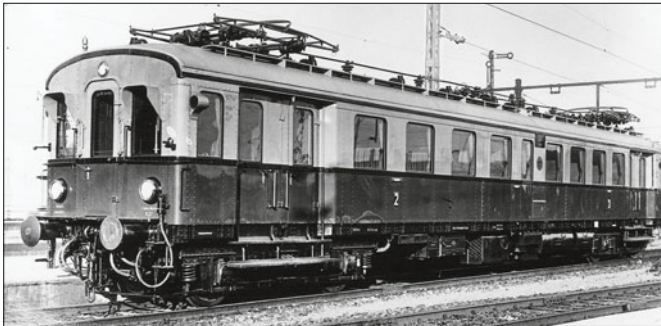
Elektrotriebwagen DRB Halle 501 (eIT 10) BC4ieIT-27 mit hell- bzw. dunkelgrauem Anstrich am Wagenkasten, schwarzen Einfassungen unter dem Dach, schwarzen Brüstungsleisten und schwarzem Rahmen (Werkfoto 1927 Wegmann Sammlung Joachim Deppmeyer)
