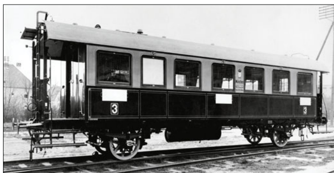
Oben links: Lokalbahnwagen Bayern 20642 CL; der Wagenkasten ist grün, Brüstungsleisten, senkrechte Deckschienen und Einfassungen sind schwarz mit weißen Absetzlinien, die Bezeichnung erfolgte durch Emailschilder mit schwarzer Schrift auf weißem Grund bzw. gelbe Anschriften mit schwarzen Schatten (Werkfoto 1906 München)
