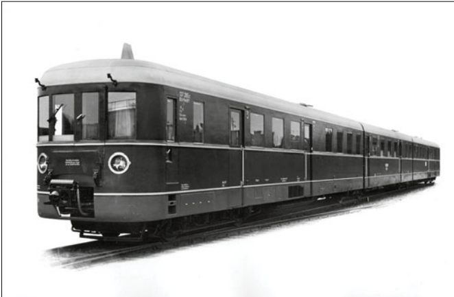
Verbrennungstriebwagen DRB 137 285 BCPw8iütrvT-35, Wagenkasten oxidrot, Dach aluminiumfarben, Zierstreifen betongrau, Schürzen umbragrau (Werkfoto 1939 Deutz Sammlung Joachim Deppmeyer)
