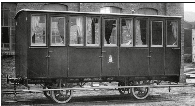
Schmalspurwagen Oldenburg Wangerooge 2 C mit braunem Wagenkasten nach preußischem Vorbild (Werkfoto 1910 Uerdingen)
