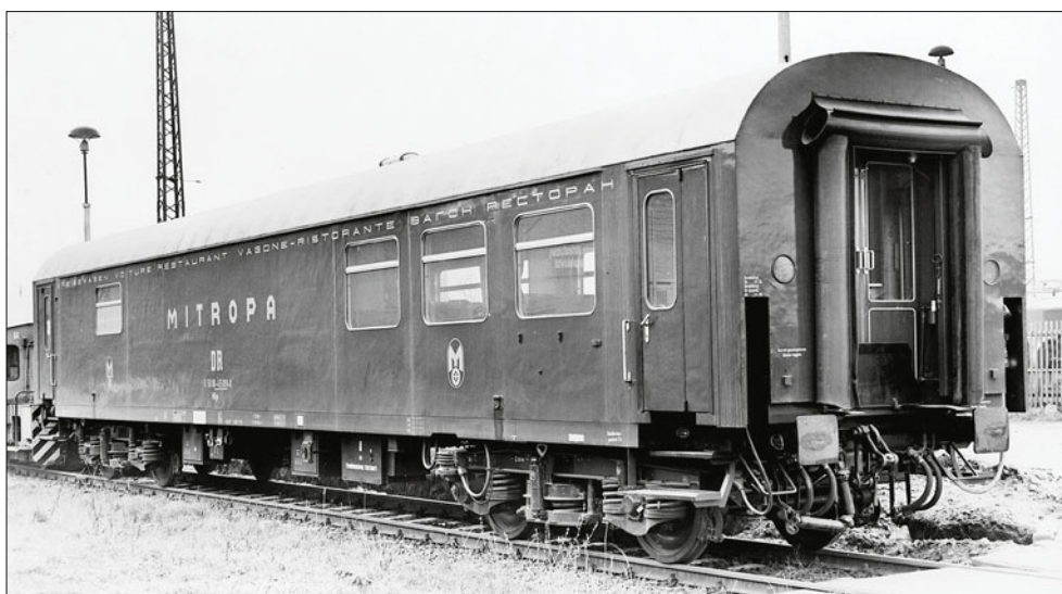
Links: Speisewagen MSG 51 50 88-45 009-0 WRge; Dach hellgrau, Wagenkasten und Langträgerverkleidung bordeaux (Foto 1974)
