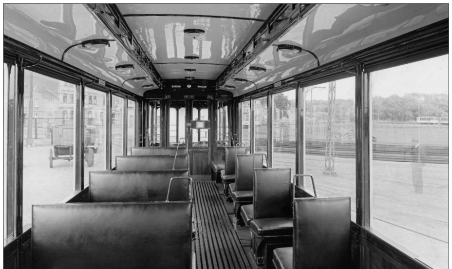
Blick in den Fahrgastraum eines 1935 gelieferten Wagens mit Polstersitzen in Abteilform und Kalottenleuchten. Diese wurden bei der Hauptserie wieder durch Glühlampen ersetzt
