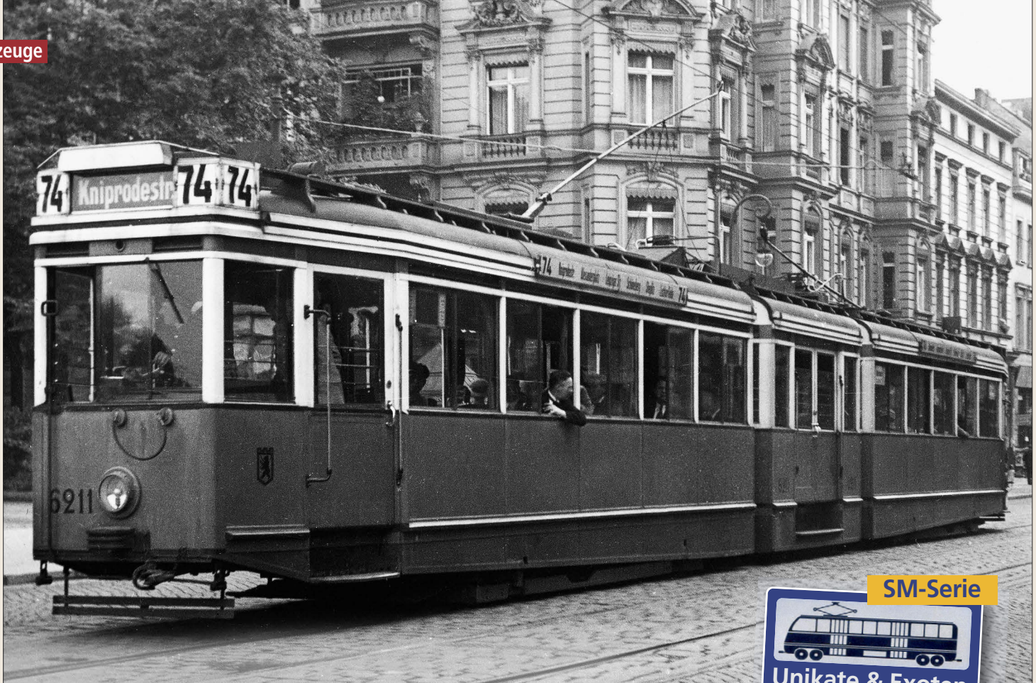
In seiner ursprünglichen zweifarbigen Lackierung gelb-weiß ist hier Tw 6211 in den 30er-Jahren auf der Linie 74 im Einsatz. Interessant auch die seitlich aufschiebbaren Fenster des Fahrgastraumes
