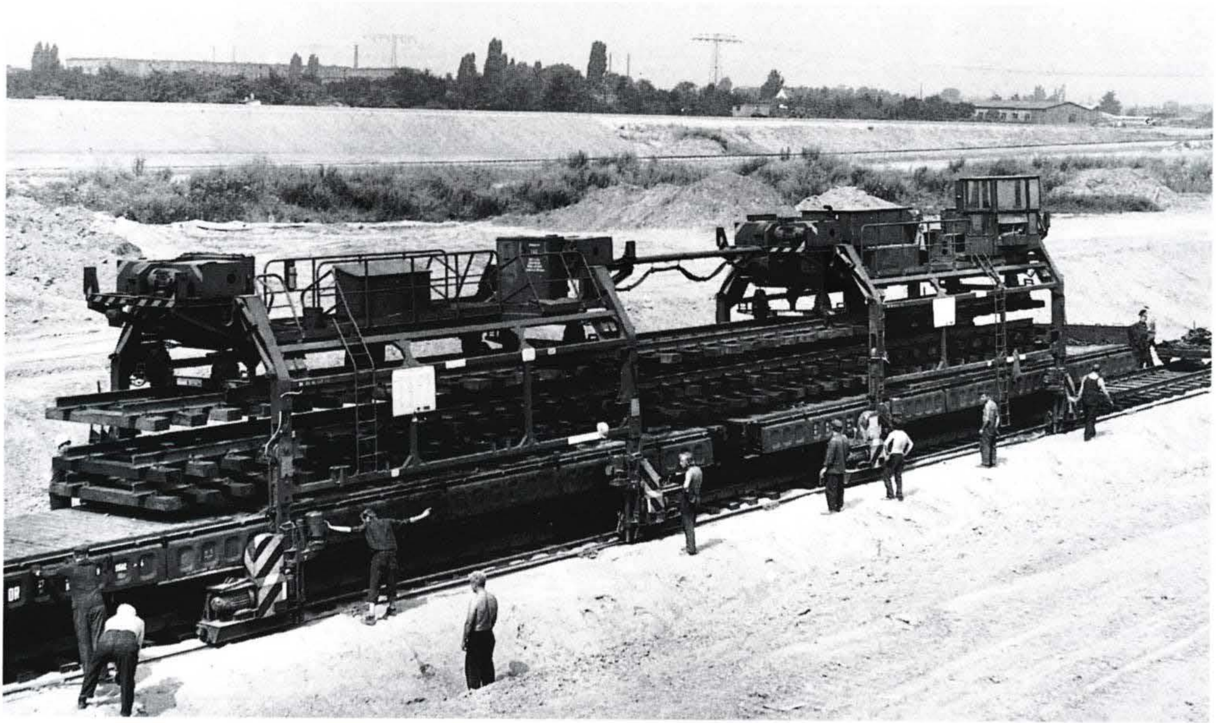
■ Die Gleisjochverlegeeinrichtung nimmt von Transportwagen die Gleisjoche ab und fährt sie zum vorbereiteten Schotterbett.
