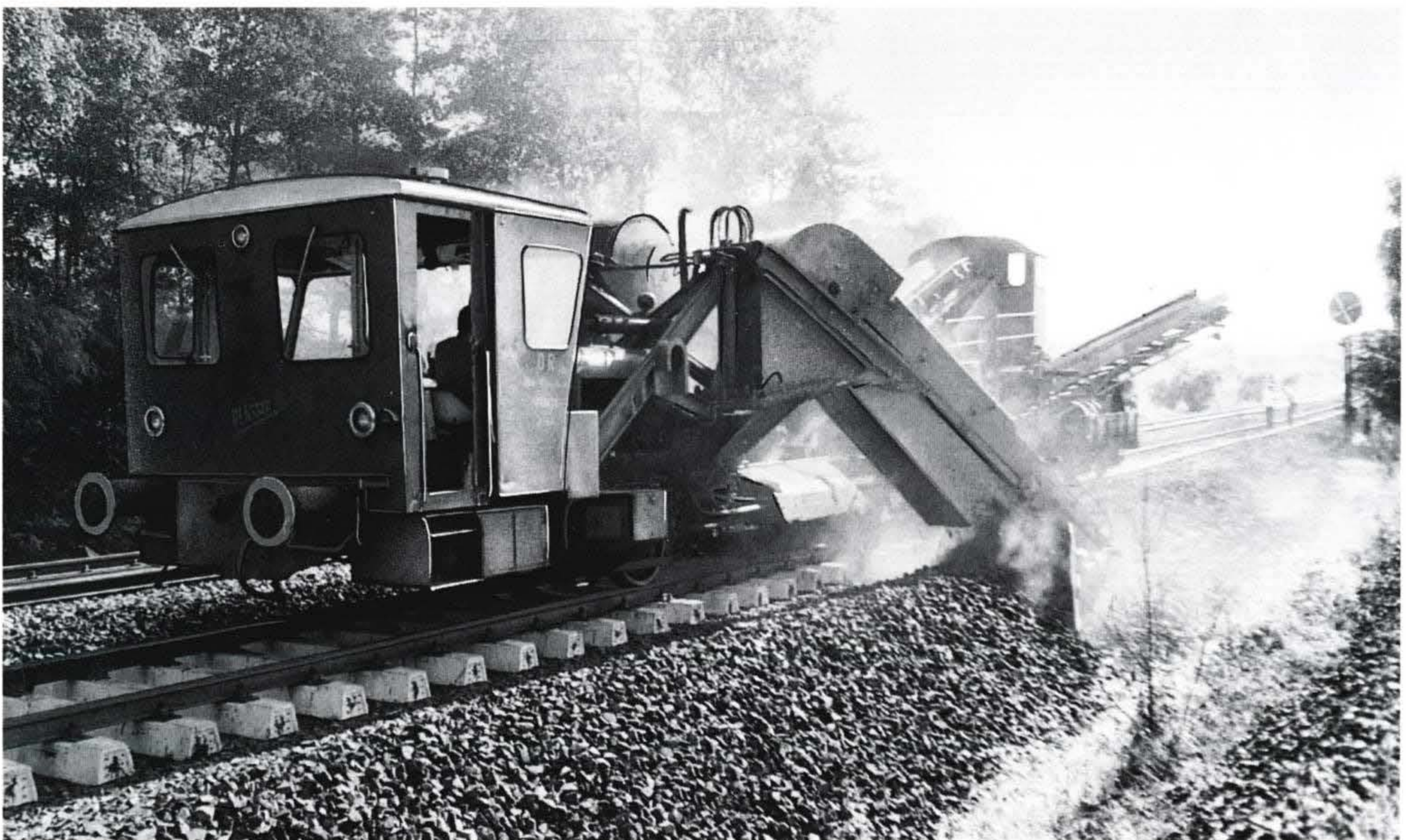
■ Der Flankenreiniger von Plasser & Theurer des Banzugs 101 bearbeitet den Außenkern und den Randweg (1970).
