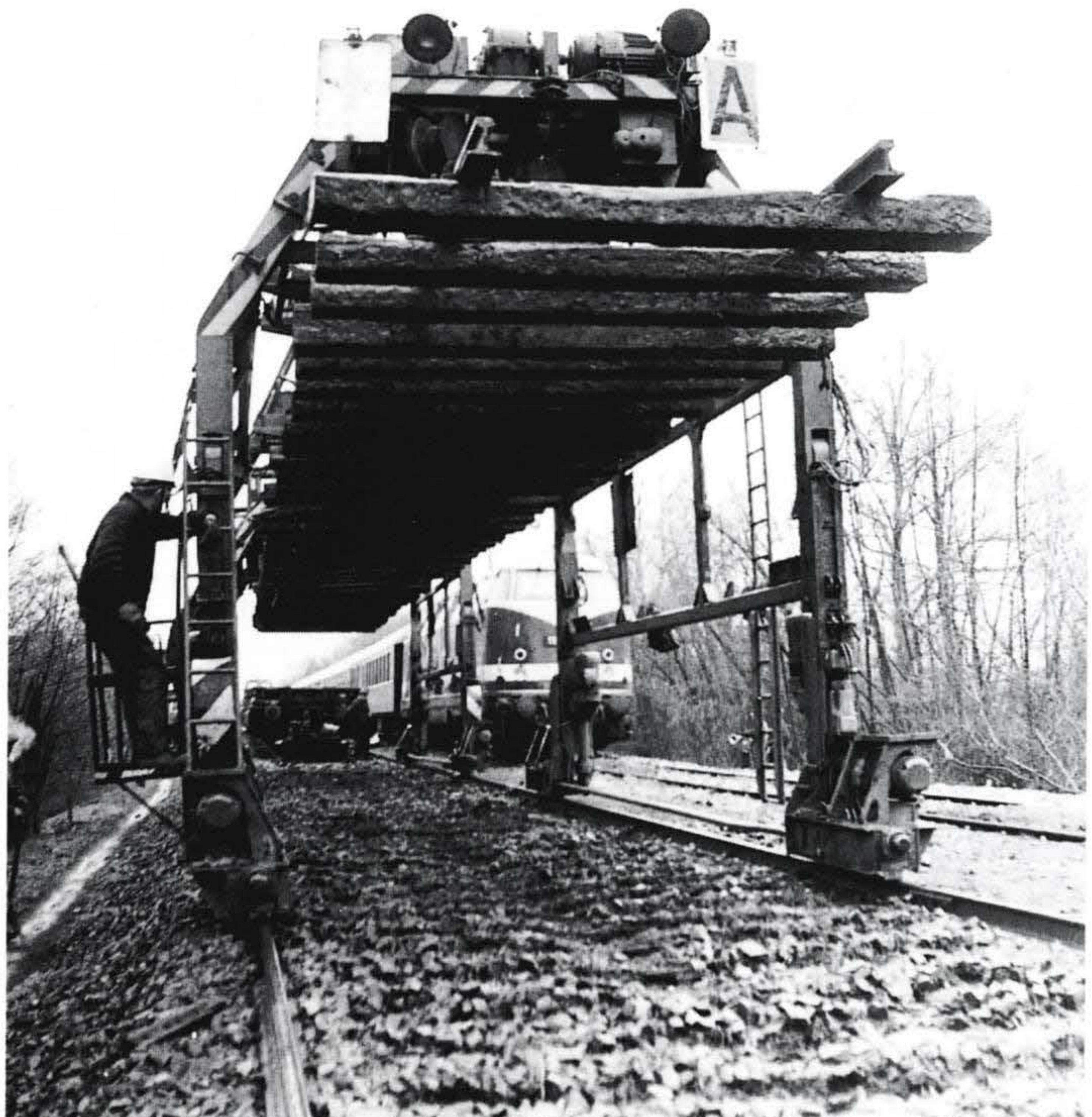
■ Ein altes Gleisjoch wurde aufgenommen und wird von der Gleisjochverlegeeinrichtung zum Rungenwagen gebracht (1972)
