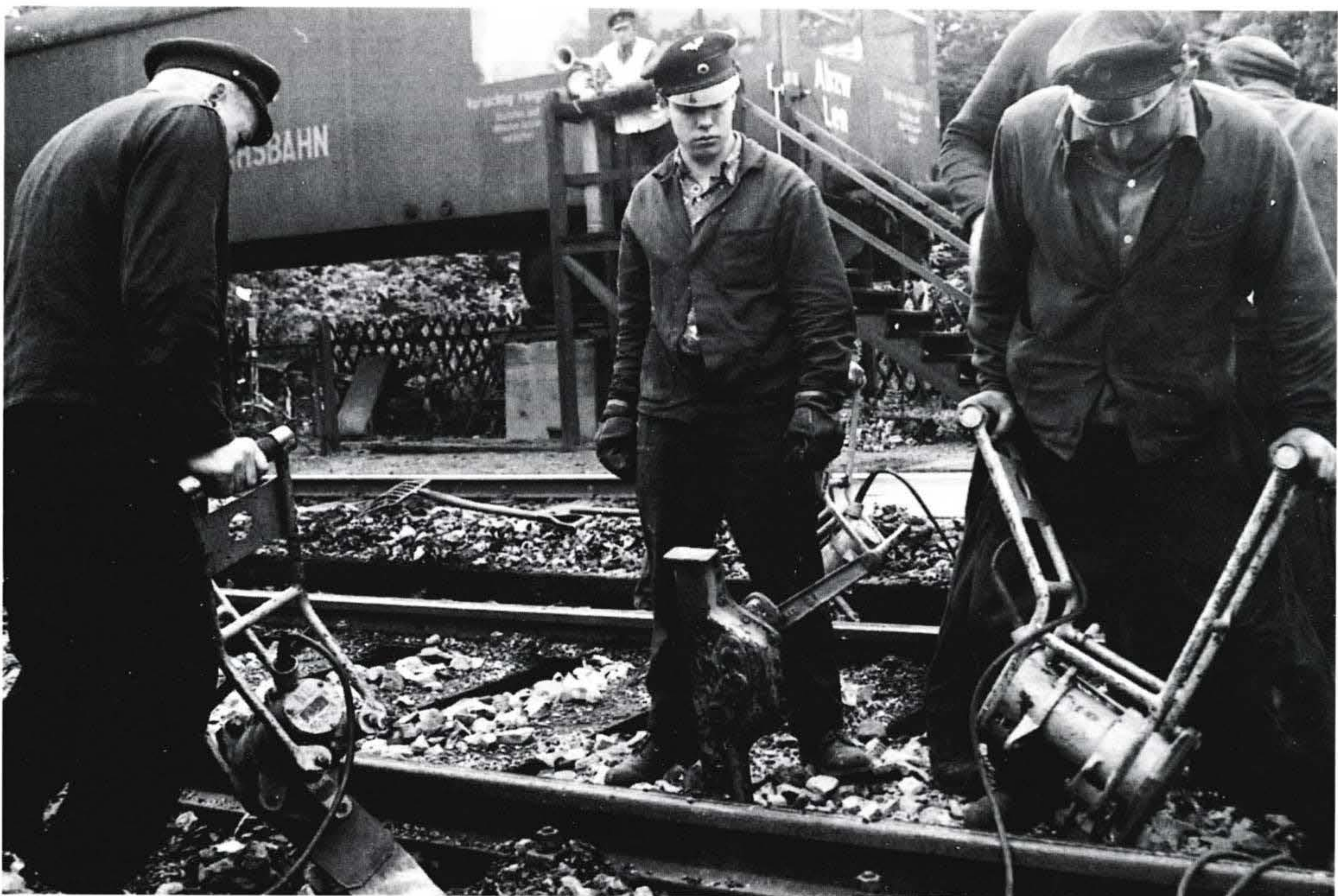
■ Schotterstopfen mit dem Vibro-Stopfer war im wahrsten Sinn des Wortes eine Knochenarbeit.
