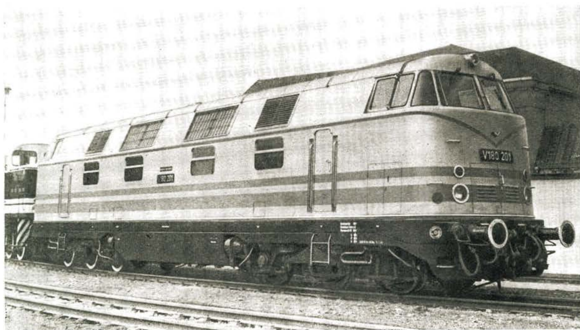
Die neue dieselhydraulische Lokomotive V 180 201 hat die Achsanordnung C'C'; sie kann mit der Achslast von 16 Mp auf allen Hauptstrecken der Deutschen Reichsbahn eingesetzt werden. Die Motorleistung beträgt 2 \times 900 PS, die Höchstgeschwindigkeit 120 km/h.
