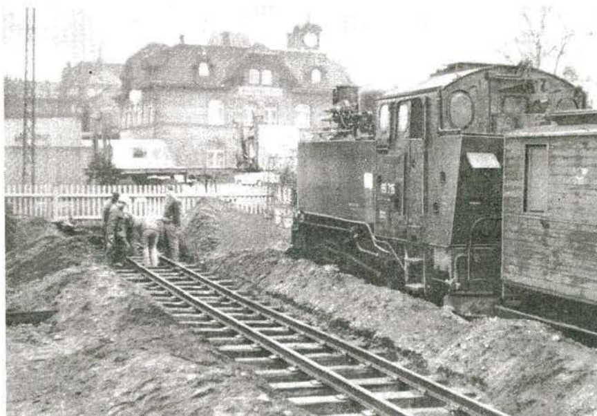
Bild 1 AG-Mitglieder bei der Gleisverlegung
