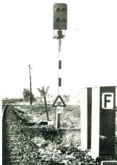
Bild 2 Beispiele für die Anbringung der einzelnen Mastschilder an Lichtsignalen
