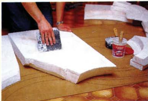
Die beiden Zwischenlagen aus Styropor werden mit Hartschaumklebstoff auf der Unterlage befestigt. Dabei hilft der Zahnpachtel.
