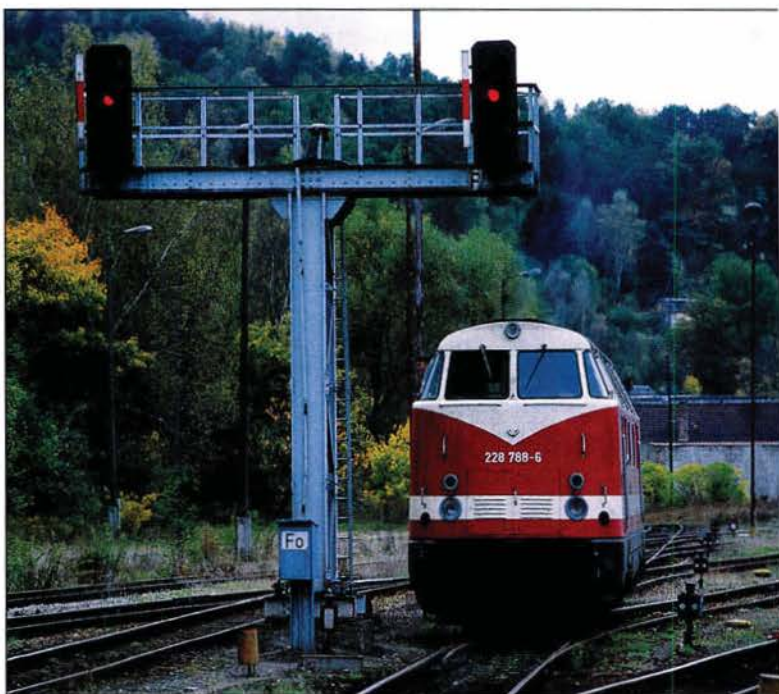
Auch für Lichtsignale wurden Signalausleger angefertigt. Der im thüringischen Rottenbach ist heute noch in Betrieb.
