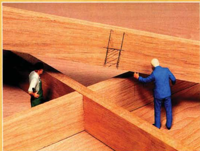
Das Schreinerteam stellt gerade eine Mittenüberplattung her, für die offene Rahmenbauweise einer Unterkonstruktion die beste Verbindung.
