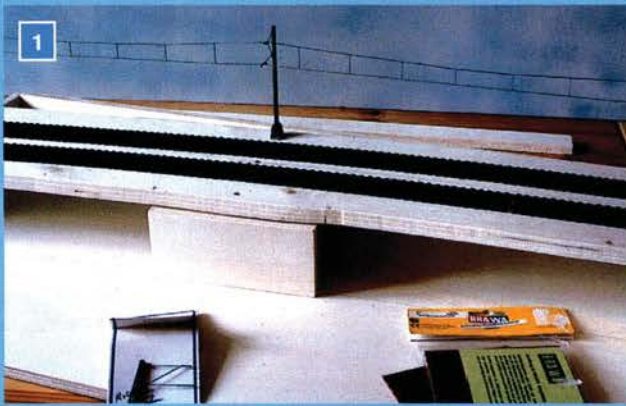
1 Bau des Grundrahmens aus Sperrholz: In dieser Phase werden auch schon Trassenbrett und Brettchen für die Spundwände eingepasst.
