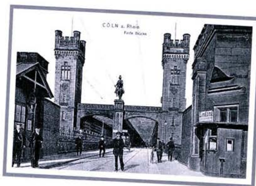
Die erste feste Kölner Eisenbahnbrücke über den Rhein hieß noch Dombrücke. Das 1855 bis 1859 errichtete Bauwerk war bereits zweigleisig und hieß im Volksmund „Mausefall“ (Mausefalle). Es stand bis 1909.
