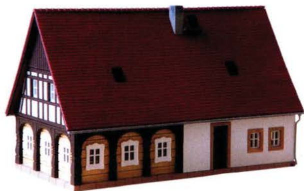
Das typische Umgebinderhaus an der Schmalspurstrecke nach Jonsdorf besteht aus einer Blockstube mit Balkenkonstruktion sowie einem Steinwerk und einem gemeinsamen Satteldach.
