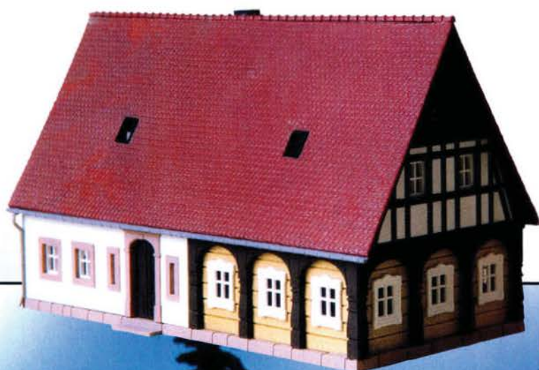
Das typische Umgebinderhaus an der Schmalspurstrecke nach Jonsdorf besteht aus einer Blockstube mit Balkenkonstruktion sowie einem Steinwerk und einem gemeinsamen Satteldach.
