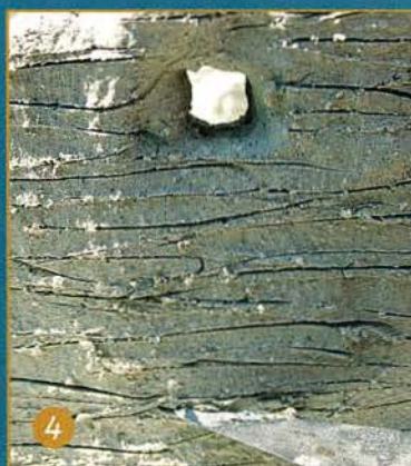
Schritt für Schritt oder Schnitt für Schnitt: Mittels Palettmesser graviert man die Mauerstruktur, bis...
