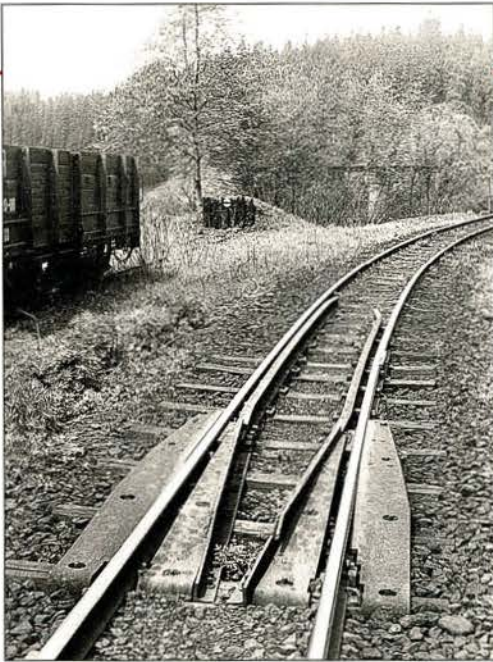
Diese Aufgleisvorrichtung vor dem Viadukt in Schönheide Süd sollte verhindern, dass entgleiste Wagen die Brücke beschädigen.
