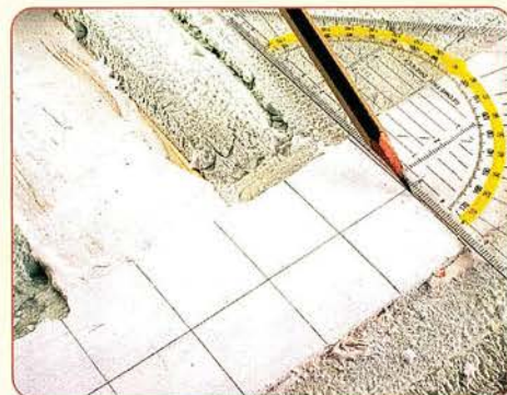
Mit einem spitzen Bleistift zeichnet man die Lage der Fugen an.
