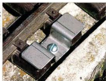
Beidseitig montierte Klemmstücke verhindern Querbewegungen.
