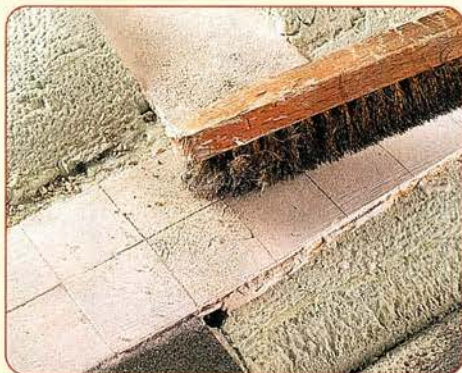
Klopft man mit einer Drahtbürste auf den Weg, entsteht eine leicht raue Oberfläche.
